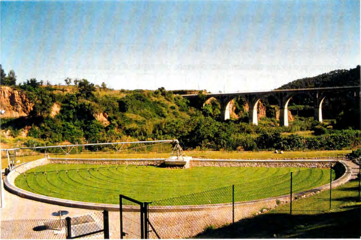
Foto 3 : Vista general del filtro de Piera (Barcelona)
