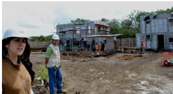
Fotografía 29. Valentina Fajreldin y el ingeniero residente en obra Felipe Cereijo, en una visita de inspección técnica con el arquitecto Rolando Quinlan a la construcción de la primera etapa del Hospital Hanga Roa el 2010. Fuente: archivo personal.
