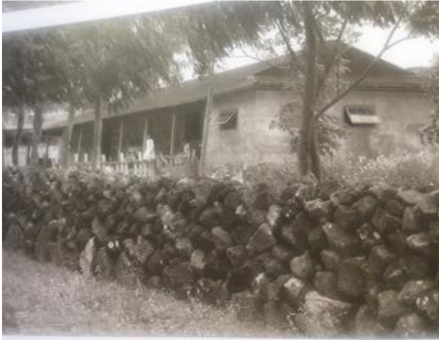
Fotografía 10. Durante la construcción de los pabellones centrales. Foto Basterrica y cols, 2016
