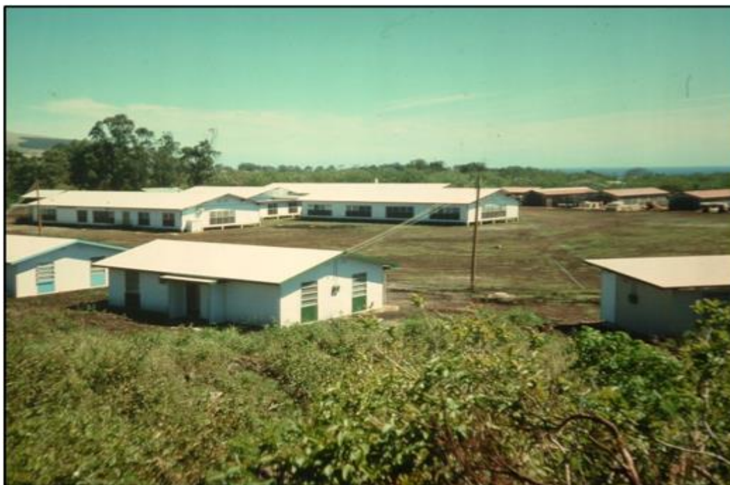
Fotografía 26. Hospital Hanga Roa en la década del 2000. Vista desde las casas de los funcionarios continentales. Fuente: Cuenta Pública HHR, 2011
