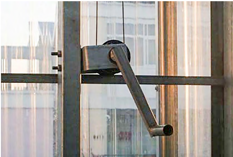
Fig. 60 Lacaton y Vassal. 2005 Edificio de 14 viviendas en Mulhouse. Detalle
