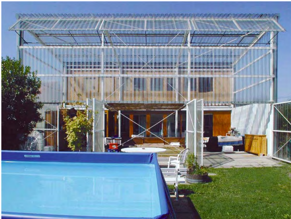
Fig. 15-16 Lacaton y Vassal. 1993 Casa Latapie. Fotografía desde la calle (2016), fotografía desde el jardín (1994)
