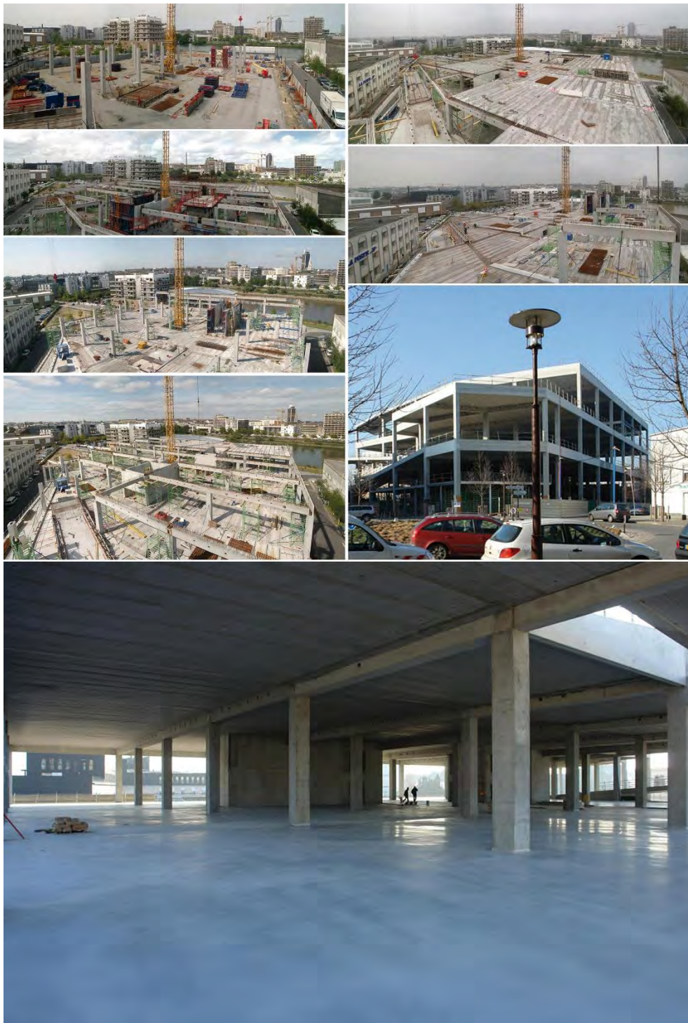
Fig. 54-61 Lacaton y Vassal. 2009 ENSA Nantes Imágenes de la construcción del 'soporte' de hormigón armado
