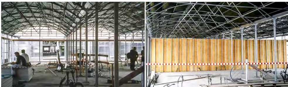
Fig. 25-28 Lacaton y Vassal. 2005 Edificio de 14 viviendas en Mulhouse. Fotografías de la obra
