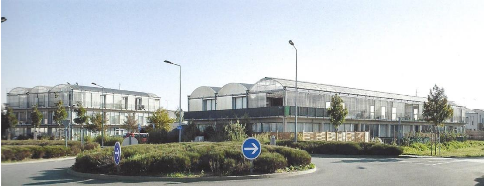
Fig. 126 Lacaton y Vassal. 2010 23 viviendas (dos edificios) en Trignac
