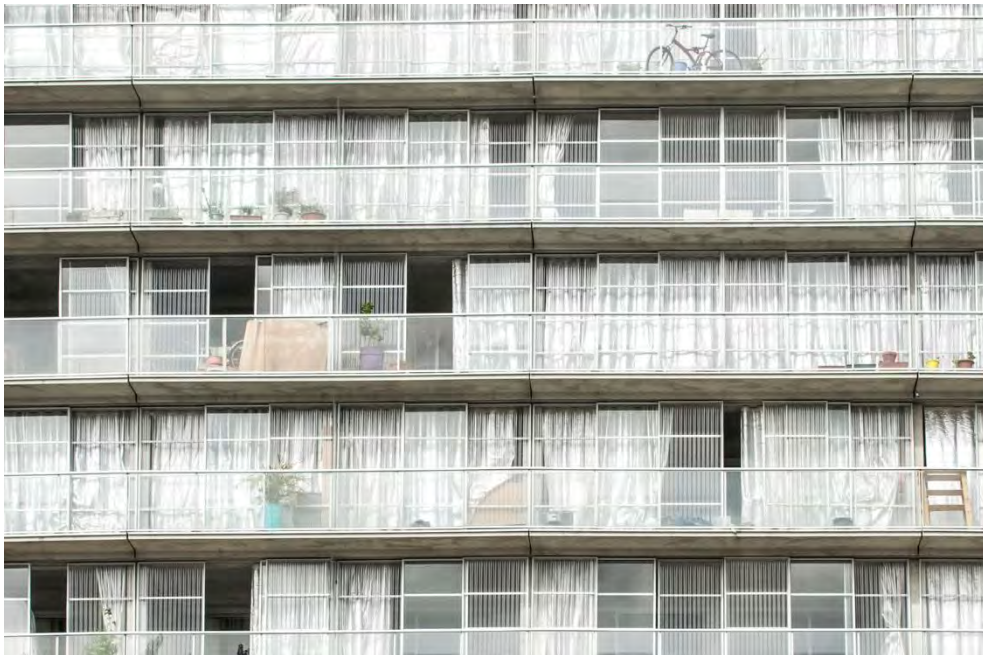
Fig. 111-113 Lacaton y Vassal, Druot, Hutin. 2016 Transformación del 530+8 viviendas en Bordeaux. Imagen interior, imágenes del proceso de obra, fachada
