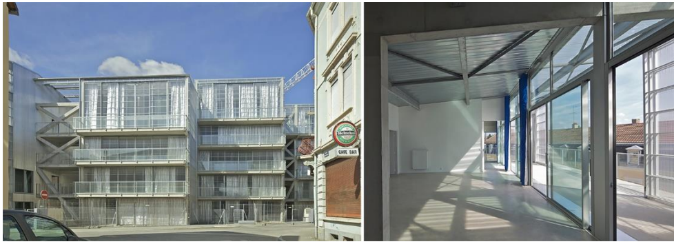
Fig. 134-135 Lacaton y Vassal. 2014-2015 59 viviendas (3 edificios) en Mulhouse
