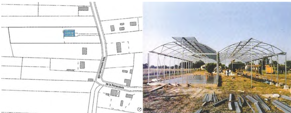
Fig. 110-111 Lacaton y Vassal. 2000 Casa en Coutras. Emplazamiento y fotografía de la construcción
