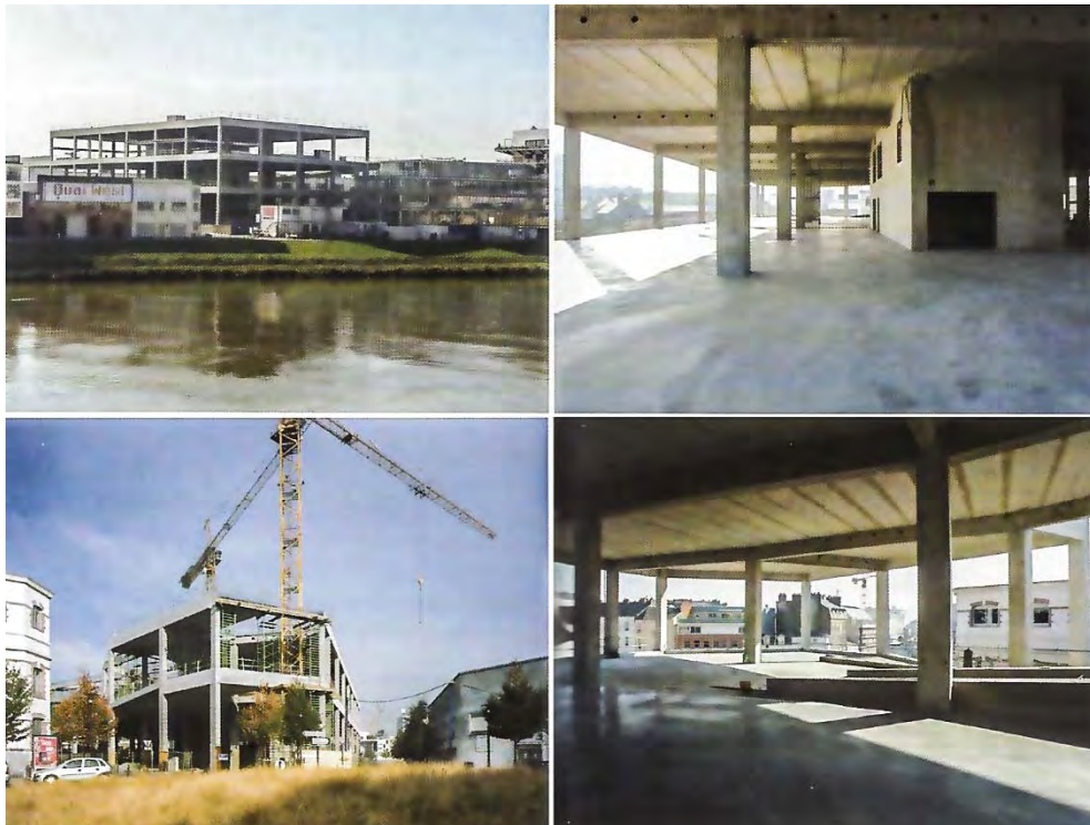
Fig. 81 Lacaton y Vassal. 2009 ENSA Nantes. Imágenes de la construcción del 'soporte' de hormigón armado
