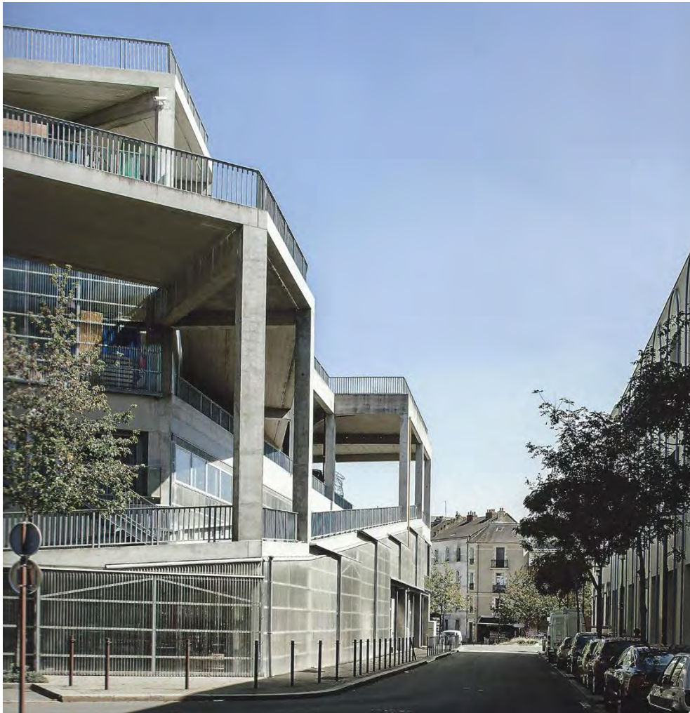
Fig. 158 Lacaton y Vassal. 2009 École d'architecture, Nantes. Imagen exterior (rampa de acceso)
