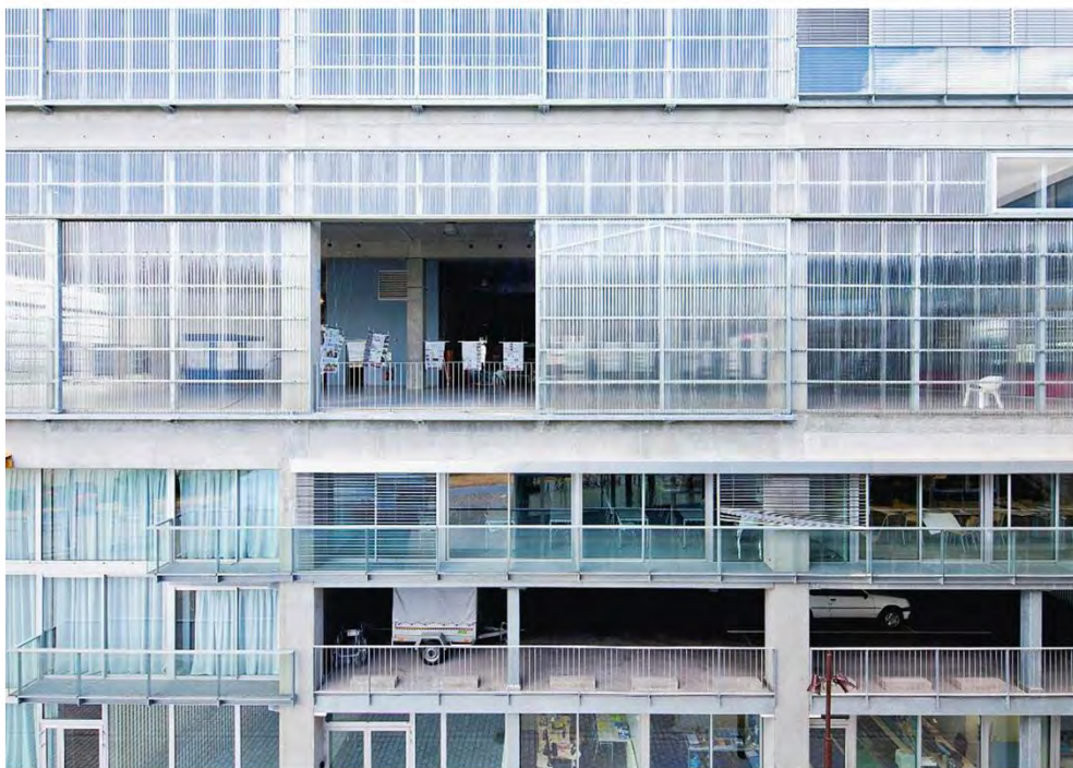
Fig. 91-92 Lacaton y Vassal, 2009 ENSA Nantes. Imagen exterior y fragmento de la fachada
