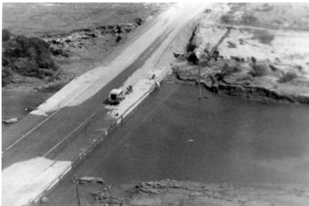
Figura 3.3. Daños producidos por el río Aguas a su paso por la carretera Al-327 en noviembre de 1989. Se puede observar la socavación por ambas partes del puente y la destrucción parcial del talud del río, además de la inundación del puente por la parte central.
