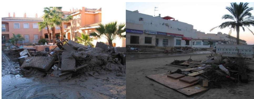
Figura 6.1. Daños en el municipio de Vera como consecuencia de la avenida.
