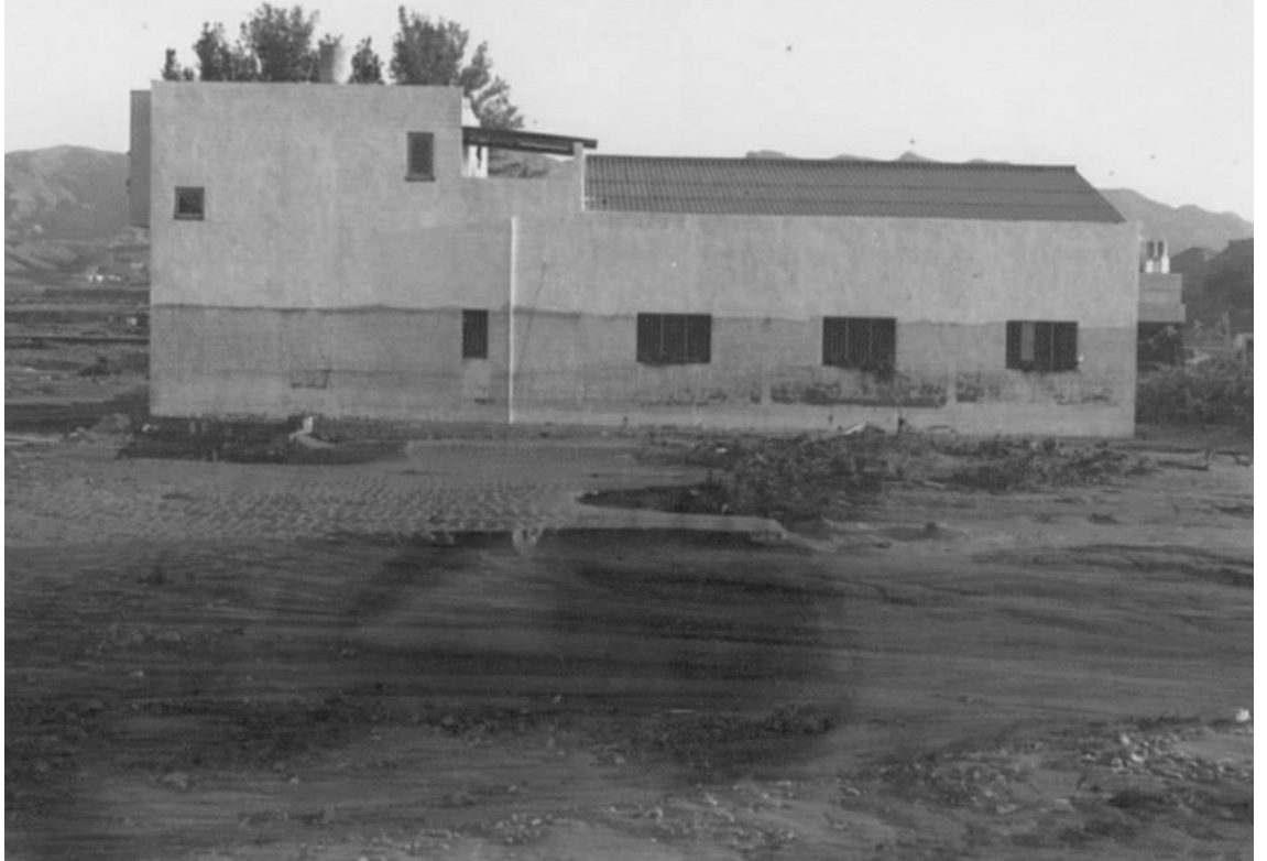
Figura 3.9. Imagen de los daños causados en las inmediaciones de la población de Cuevas, concretamente en el barrio del Pilar. Fuente: Archivo privado.
