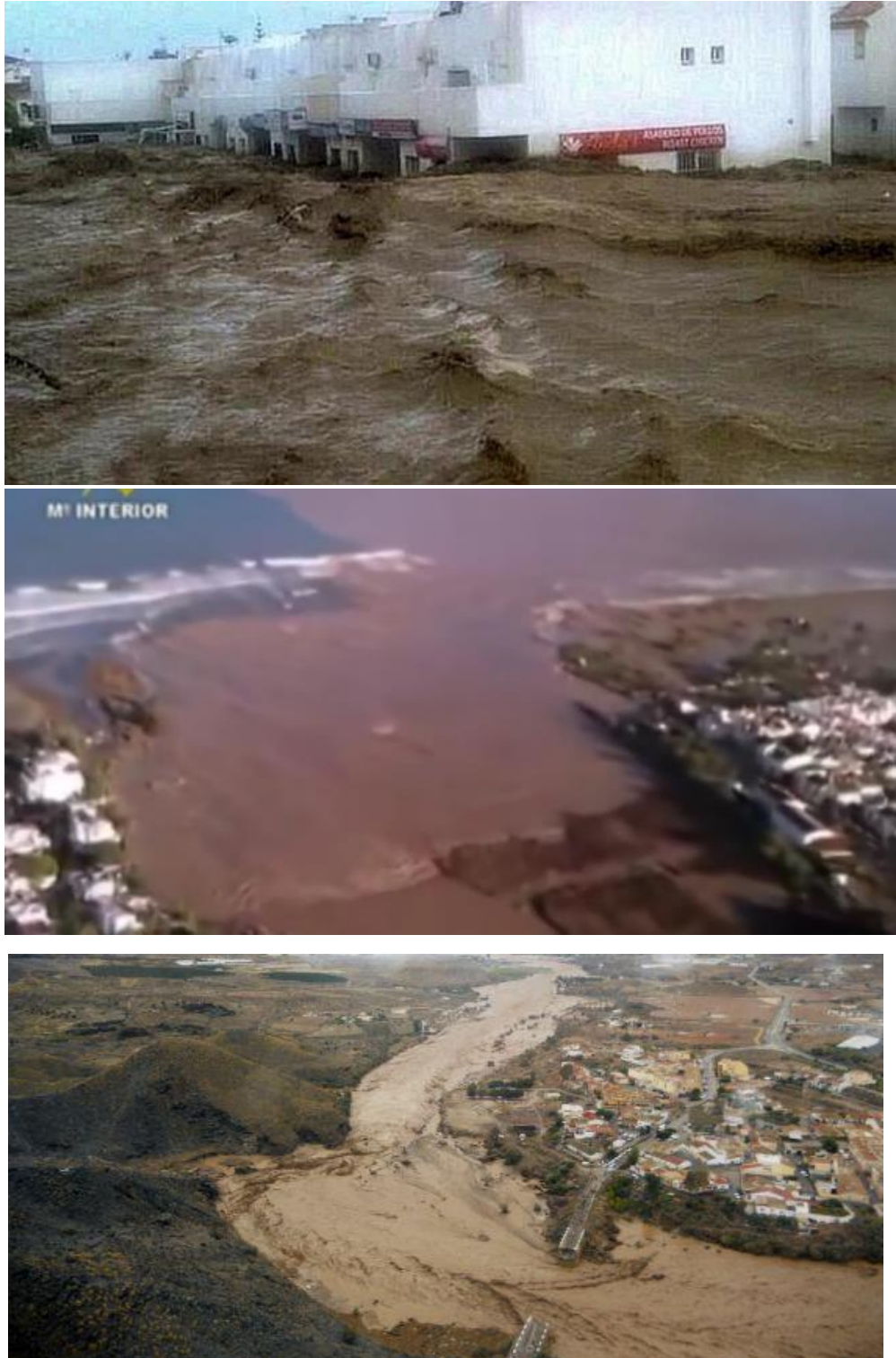
Figura 3.11. Superior: Río Antas a su paso por la Urbanización de Vera playa. Fuente: Ayuntamiento de Vera. Centro: Desembocadura del río Antas en la localidad de Vera. Fuente: Ministerio del Interior. Inferior: Imagen aérea del río Antas en el momento de máxima crecida a su paso por la localidad de Antas, se puede observar como el puente quedó totalmente destruido. Fuente: Ministerio del Interior y Ayuntamiento de Antas.
