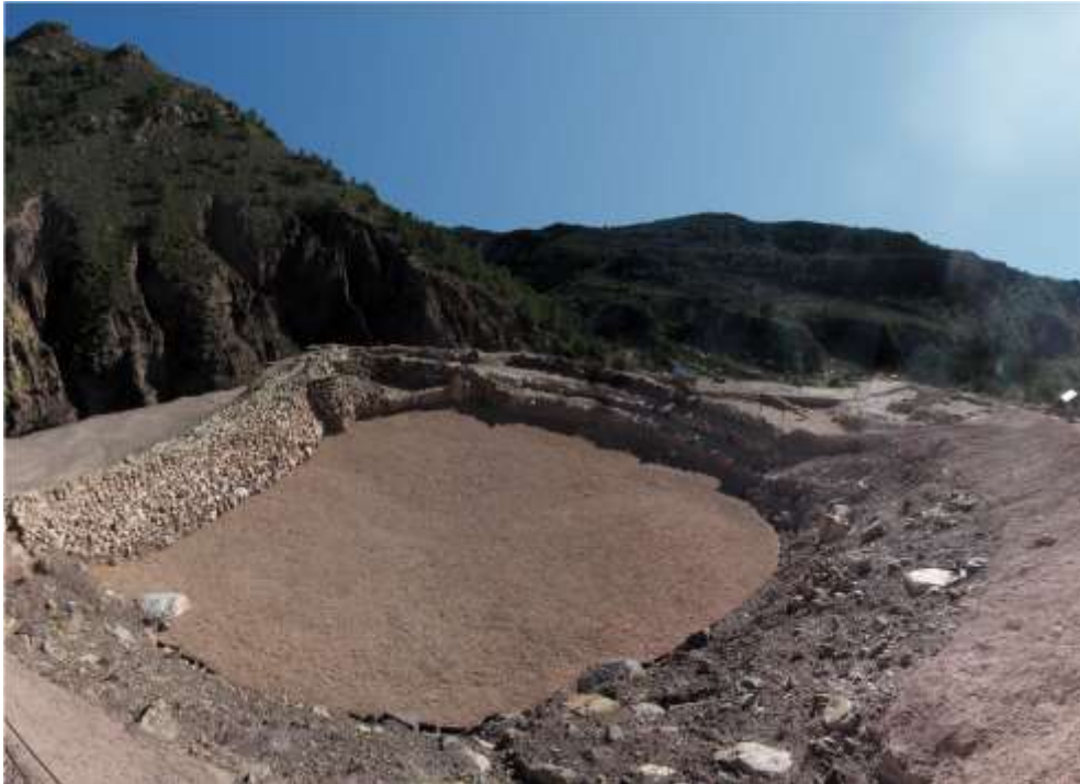
Figura 4.7 Vista general de la balsa de La Bastida desde el Noroeste. Foto: ASOME.
