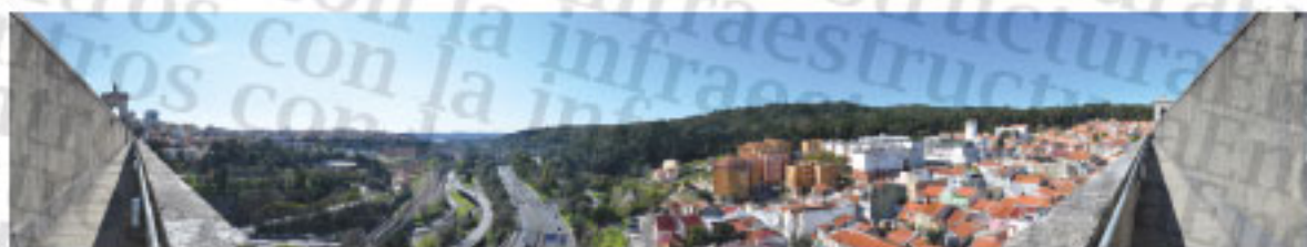
(F162) Valle de Alcántara desde lo alto del acueducto en el lado sur.
