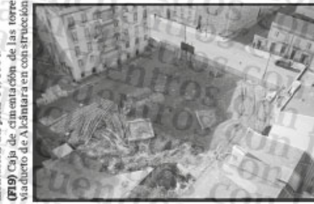
(F19) Caja de cimentación de las torres del Puente 25 de Abril y pilares del viaducto de Alcántara en construcción al fondo, c.1962.
