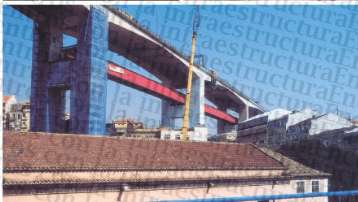
(F11) Lanzamiento de la vía ferroviaria sobre el barrio de Alcántara.
