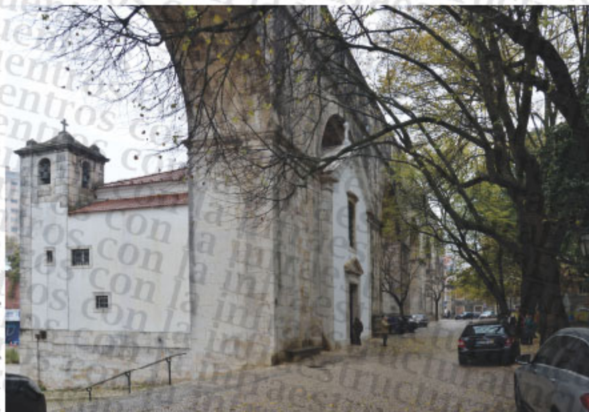
(F80) Encaje de la capilla en uno de los arcos del acueducto. Alzado sureste.
