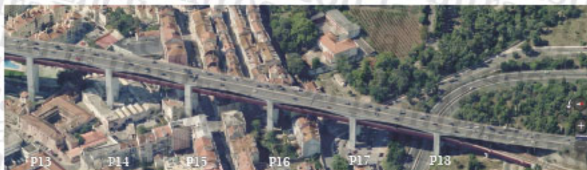
(F41) Vista aérea de los pilares 13 al 18 sobre el barrio de Alcántara
