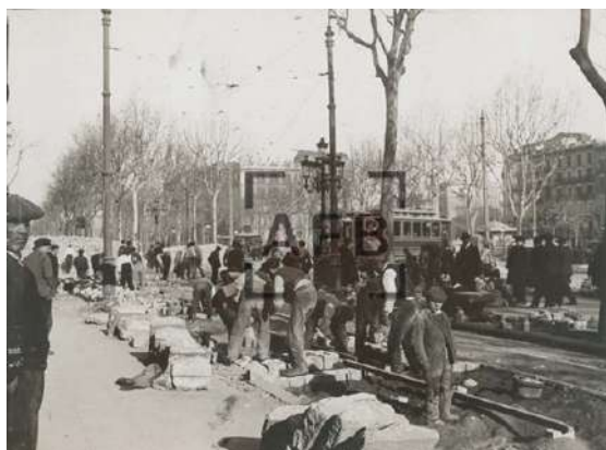
04.17. Empedrant la Gran Via. 02/1906. AFB bcn001066.
