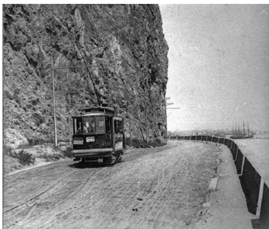
04.30. Tramvia de la línia 48 en la carretera del Morrot. ICC RF.6246.
