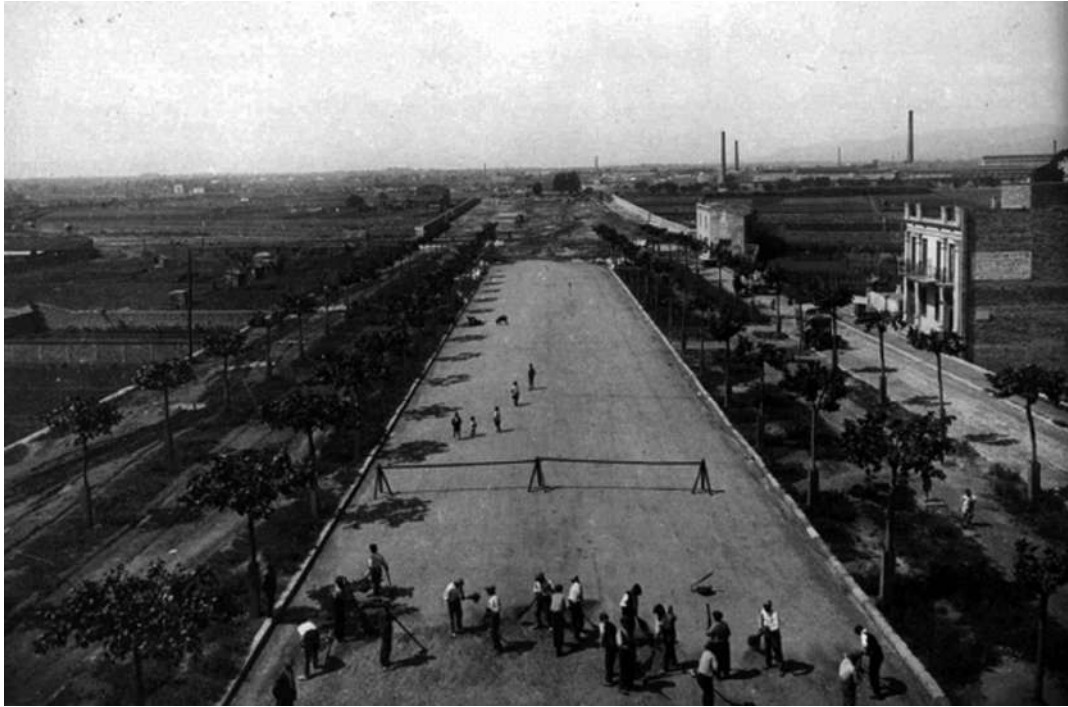
03.01. La Gran Vía en construcció
