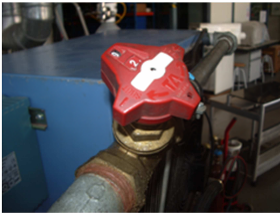
Fig. 4.16. Válvula de equilibrado STAD.
