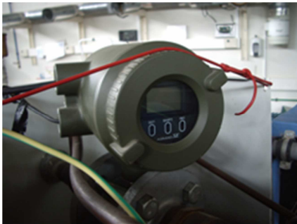
Fig. 4.14. Caudalímetro electromagnético del CDC.
