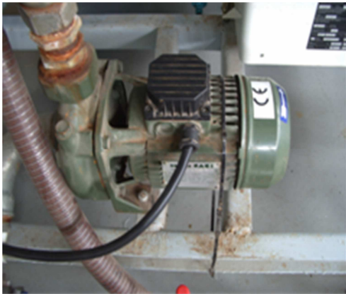
Fig. 4.11. Bomba de empuje del CDC.
