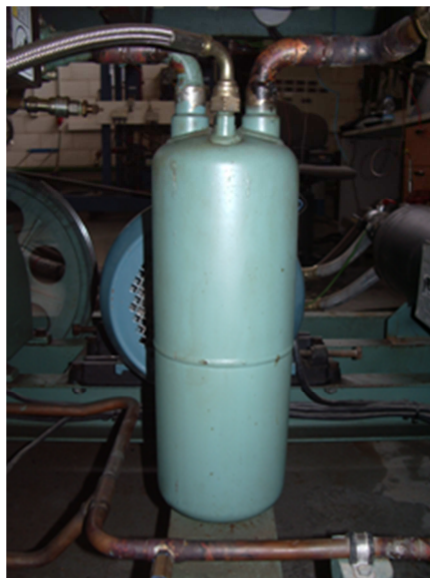
Fig. 4.19. Botella de separación de aceite.
