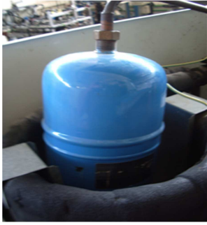
Fig.4.13. Vaso de expansión del CDC.
