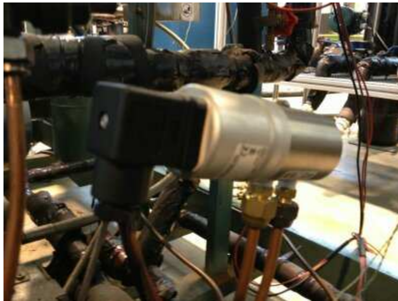
Fig. 4.27. Sondas diferenciales de presión.
