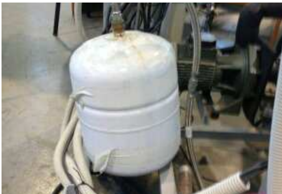
Fig. 4.4. Vaso de expansión del CAC.
