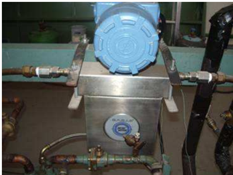
Fig. 4.29. Caudalímetro másico
