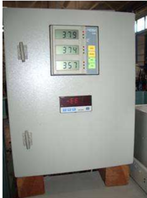
Fig. 4.30. Analizador de redes
