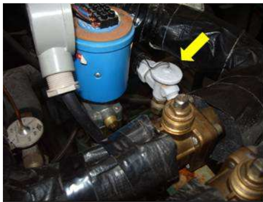
Fig. 4.22. Válvula de expansión termostática.
