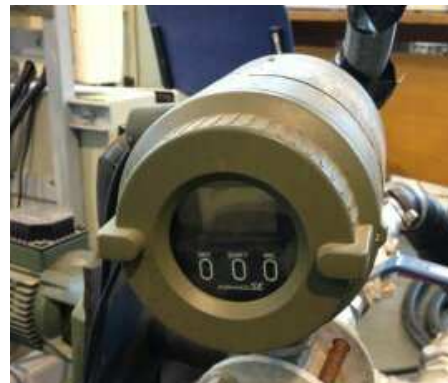
Fig. 4.5. Caudalímetro electromagnético del CAC.
