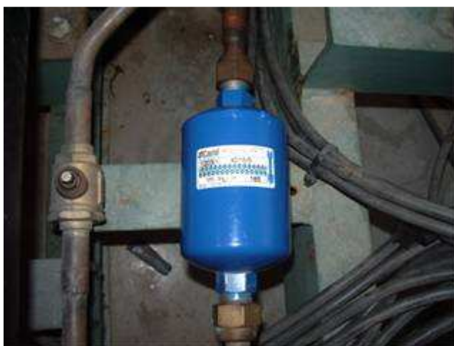
Fig. 4.21. Filtro deshidratador.
