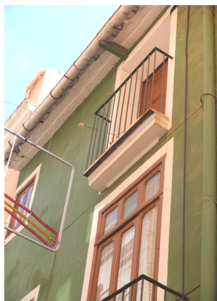
Antigua casa de obrador, aún con la viga de madera que sujetaba la polea por debajo de la cubierta Fondo documental: Concepción Calvo
