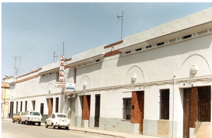
Cooperativa Obrera de Casas Baratas, en Bovalar (foto sup.) y Mestrets (foto. inferior) Fuente: Peñin, A.; Grande, F.; Varela, S. (1988): «Arquitectura y Urbanismo.1910-1936»
