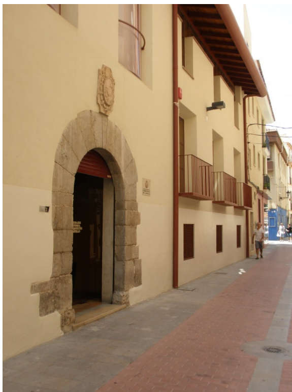
Escuela de niñas de la calle Enseñanza. Actualmente sede del Colegio de Arquitectos de Castellón. Foto: Concepción Calvo
