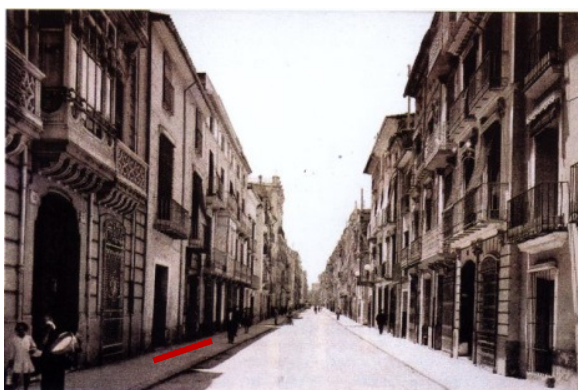
Escuela Centro de niños, calle Mayor, 126. Segunda casa del lado izquierdo de la calle. Fuente: Colección fotográfica: Morales, M; García L., Castellón sigloXX
