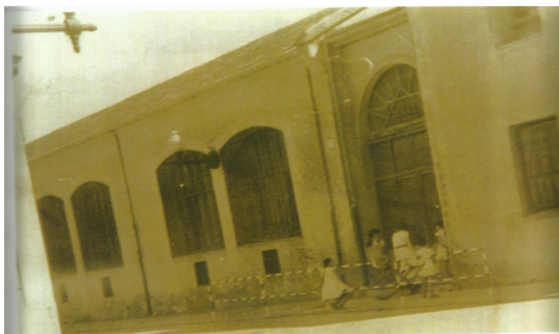
Grupo Escolar de la calle Herrero. Fondo fotográfico: Colección José Prades Se puede observar en la parte inferior de la fachada los huecos para la ventilación cruzada de las aulas.
