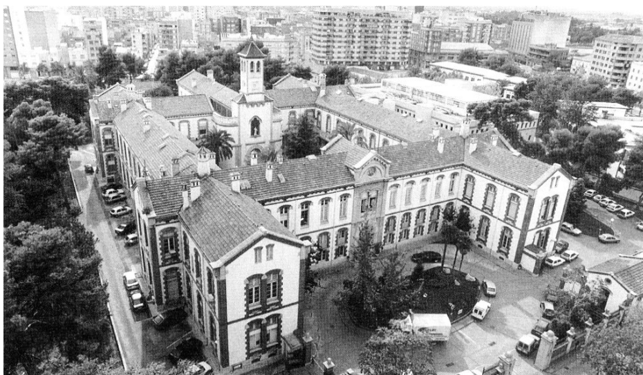
Vista desde el acceso principal del Hospital Provincial de Castellón: Fuente: Mir Soria, Patricia y Fuster Garcia, Pascual (2010): Manuel Montesinos Arlandiz. Arquitecto provincial y exponente del eclecticismo en Castellón
