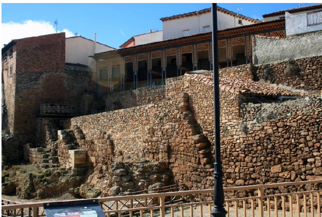
Foto 11 Restos de las murallas del Barrio Moro 197
