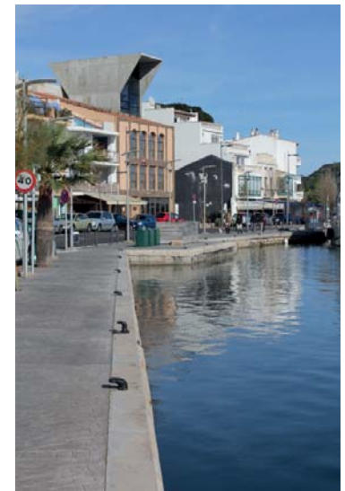
01 Vista de conjunt de l'ascensor a la façana del Moll de Llevant. 2015, Fotografia de l'autor.
