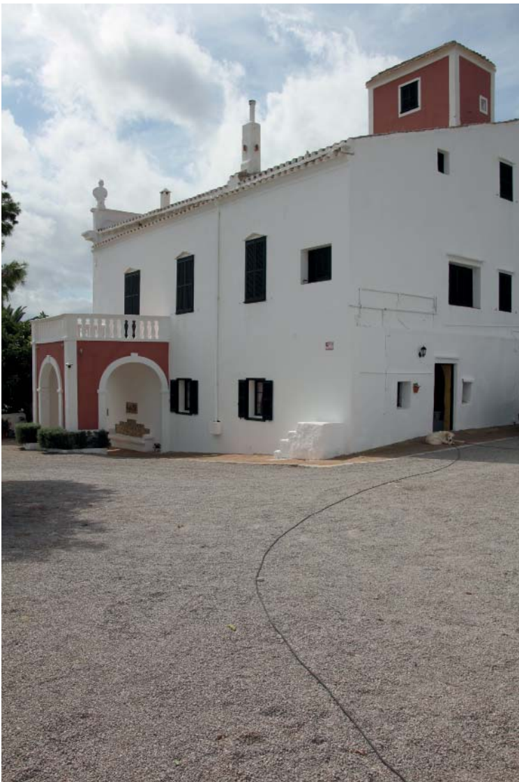
04 Imatge de la façana posterior. Fotografia de l'autor
