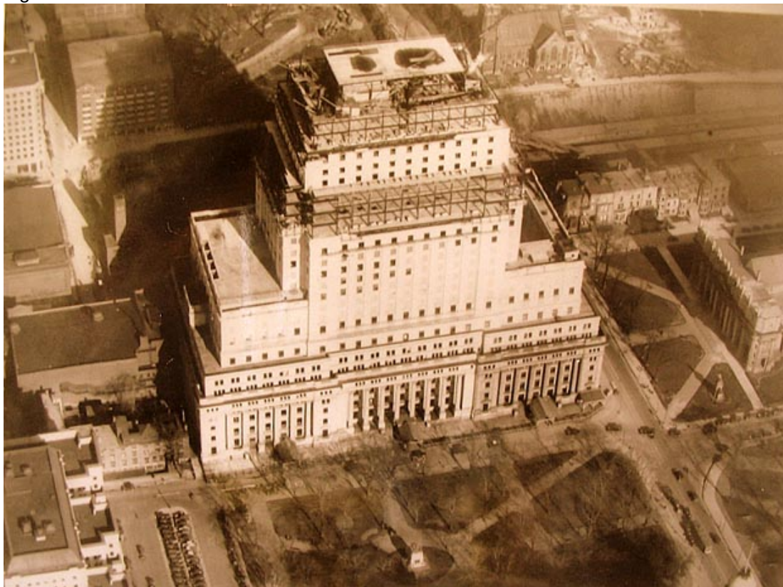
Figura 110 Construcción de la torre del edificio de la Sun Life
