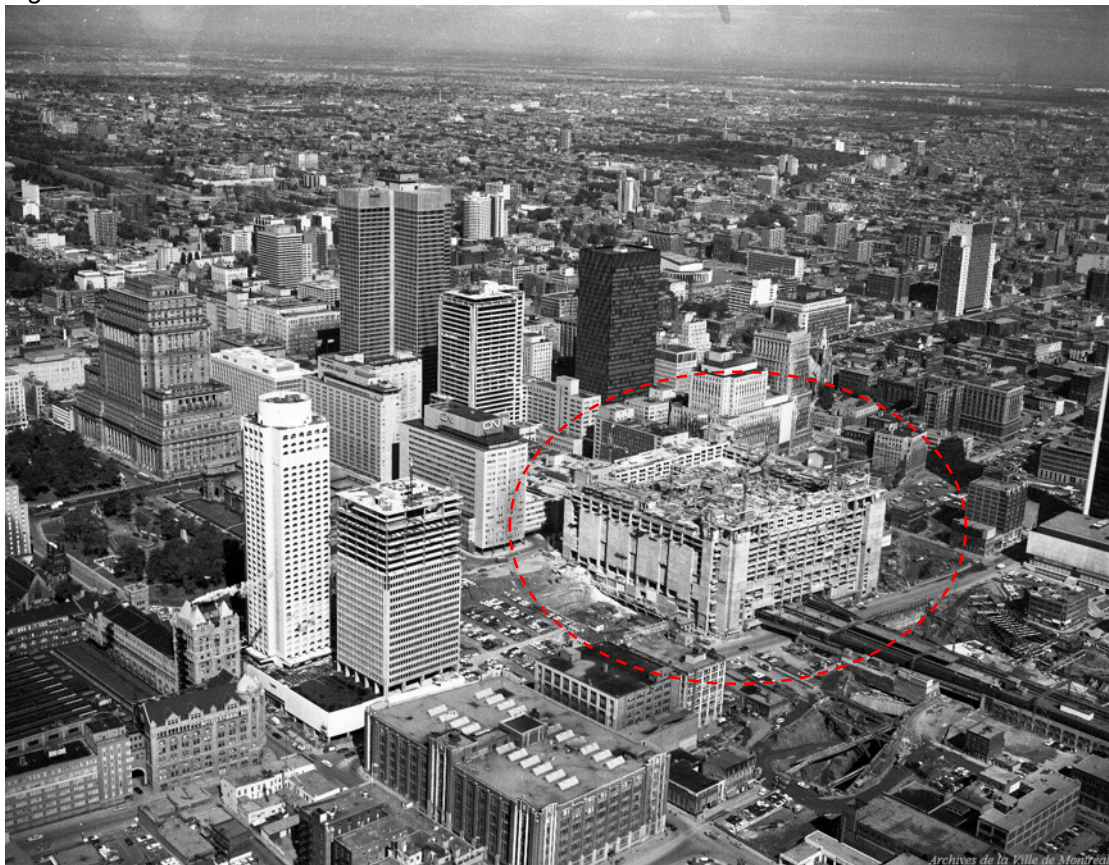
Figura 124 La construcción de la Place Bonaventure en 1966
