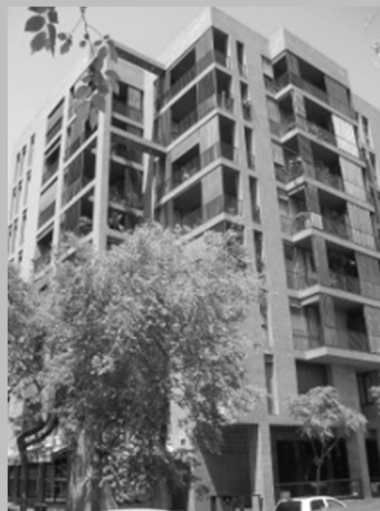
INICIO 31.9.2013 06:00h C. Trias i Giró, 15-19. Distrito: IV. Les Corts. Barrio: 21. Pedralbes. 08034, Barcelona.
