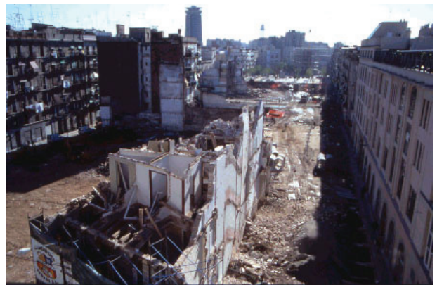
2.36 Obras de derribos para la ejecución del Plan Central..
