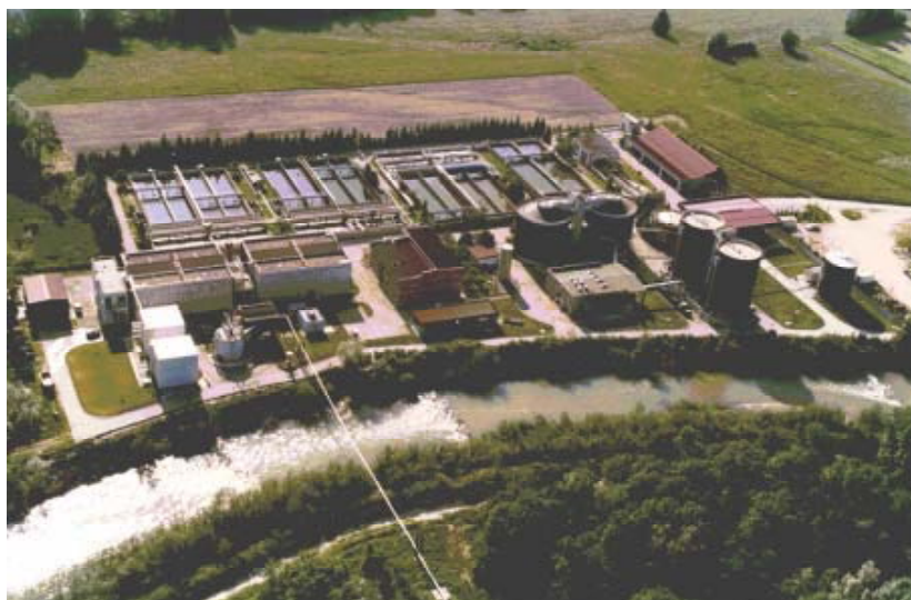
Figura 19.1: Vista aérea de la planta (1999).
