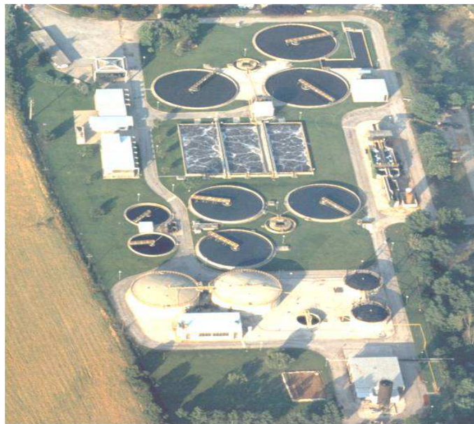
Figura 14.1: Vista aérea de la EDAR Catalana.
