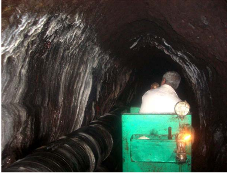
Figura 5.6. Foto del interior de la galería N° 5 (LGA) en el sector occidental de Las Cañadas, donde se pueden apreciar los precipitados de carbonato cálcico de color blanquecino en sus paredes y techo, así como la tubería de ventilación (abajo izquierda) para introducir aire "limpio" del exterior de la galería y/o extraer el aire "contaminado" por las emanaciones gaseosas del interior de la misma.
