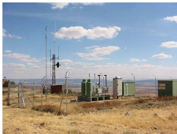
Figura 1.- Vista general E-W de la estación de Risco Llano (Toledo)
