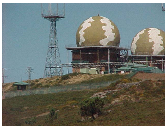
Figura 1.- Vista general del entorno de la estación de Noia (A Coruña)
