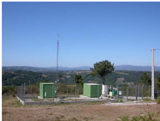
Figura 1.- Vista general E-W del entorno de la estación de O Saviñao (Lugo)
