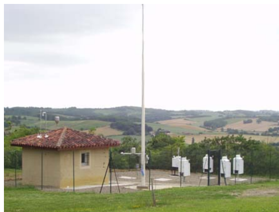
Figura 1.- Vista general S-N de la estación de Peyrusse Vieille (Francia)
