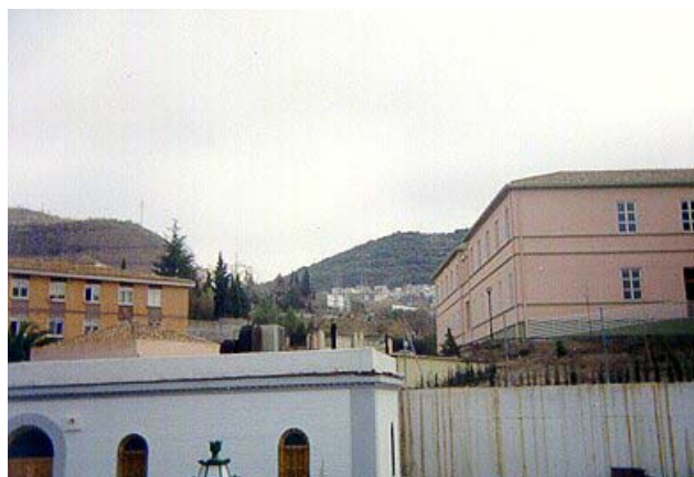
Figura 1.- Vista general N-S de la estación de La Cartuja (Granada)
