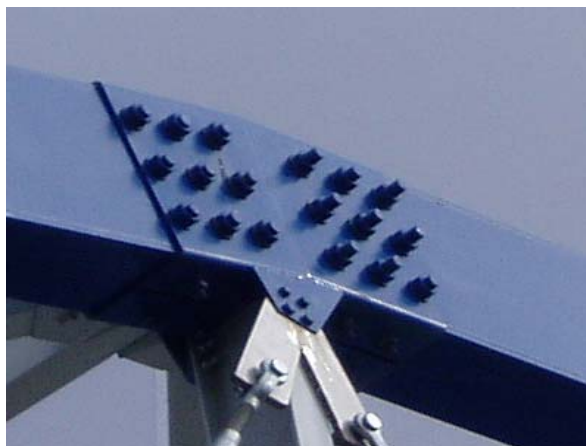
Figura 4.5. Ejemplo de unión atornillada (puente del A.V.E, Lleida)
