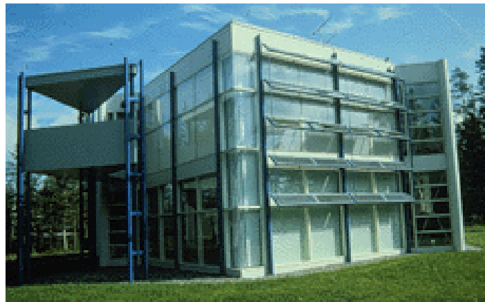
Figura 2.8. Edificio Nesthaus (Finlandia)
