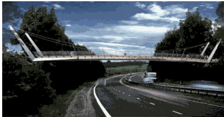
Figura 2.7. Vista general de puente ligero de MC
