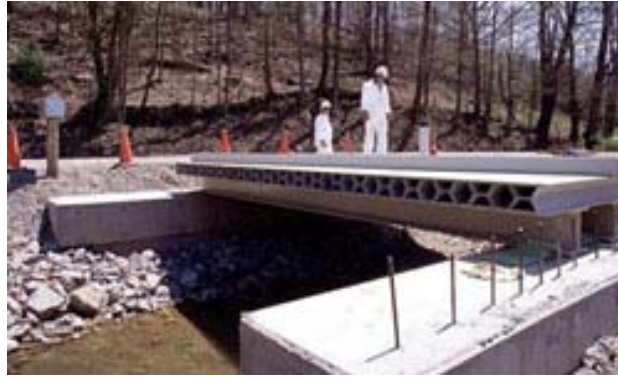
Figura 2.5. Tablero Superdeck presentado
