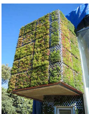
Figura 92. Paramento vegetal vertical. Intemper [12]
