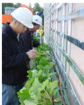
Figura 56. Green Wall Panels. Muntatge.
