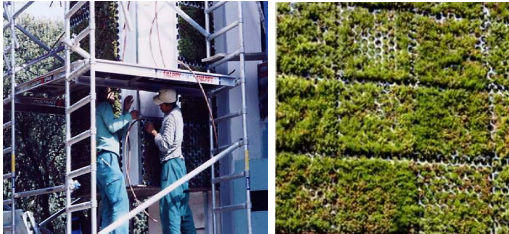
Figura 69. Paramento vertical. Muntatge [42]
