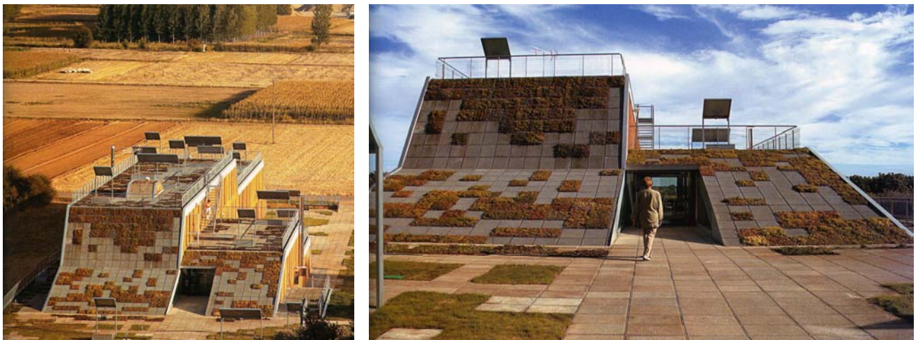
Figura 70. Paramento vertical. Residència d'avis a Zamora [43]
