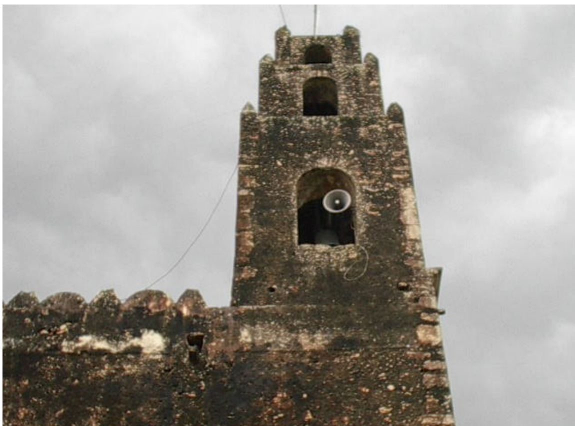
Figura 59. Detalle de unión entre el muro de la nave y la torre de la iglesia del ex convento de Temax. Torre agregada probablemente en el S. XVIII
