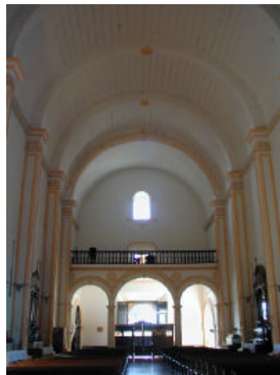
Figura 41. Interior de la iglesia de Espita. Pilastras y arcos que refuerzan la nave.
