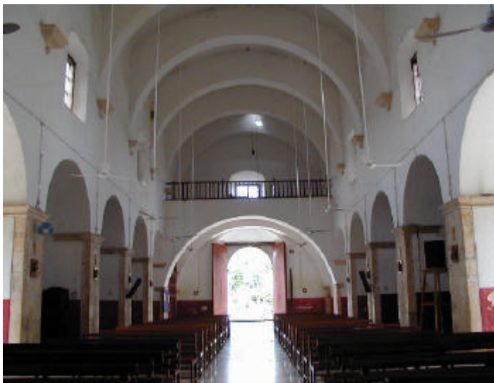
Figura 40. Interior de la iglesia conventual de Hochtún. Pueden apreciarse los Arcos fajones y formeros en la nave.
