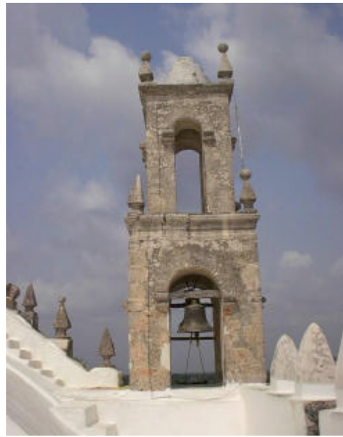
Figura 29. Torre de la iglesia parroquial de Motul. Agregada al secularizarse.
