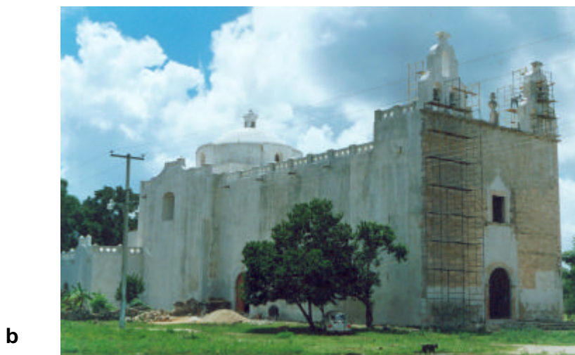
Figura 44. Iglesia del santuario de Tabi. Visita de la parroquia de Yaxcabá. a , Planta; b , Vista exterior
