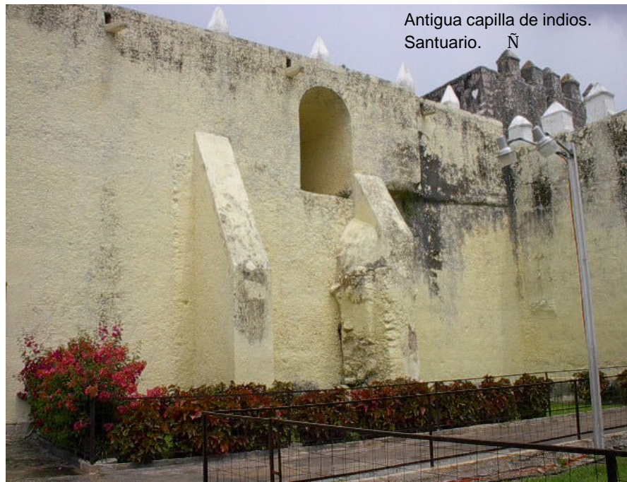
Figura 54. Antigua capilla de indios del ex convento de Cansahcab. Se puede observar que esta capilla tiene nivel más alto que la nave y elementos de remate con un espaciado menor.
