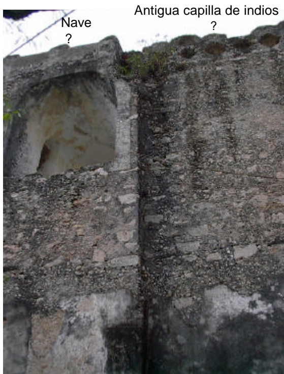
Figura 56. Junta constructiva entre capilla de indios y nave de la iglesia del ex convento de Temax.
