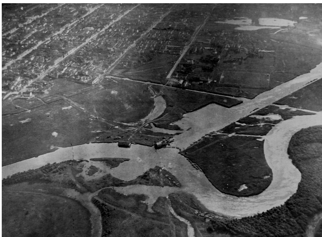
fig 47 - Canalização do rio Tietê nas proximidades do Bom Retiro.
