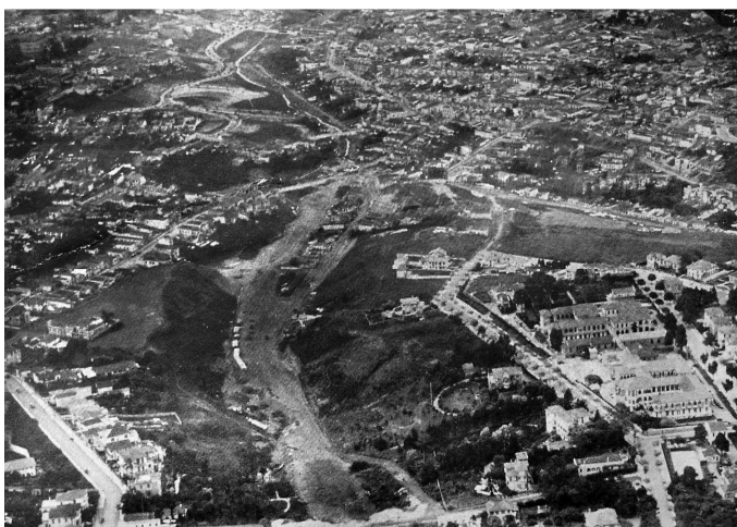
fig 20 - Vista da construção da Avenida Anhangabaú, uma das cunhas verdes propostas por Maia.
