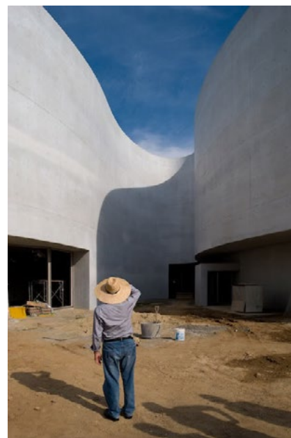
4403. Siza visitando el Museo Mímesis en construcción. Septiembre de 2008.
