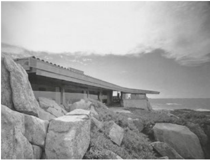
2124. Vista de la fachada oeste.
