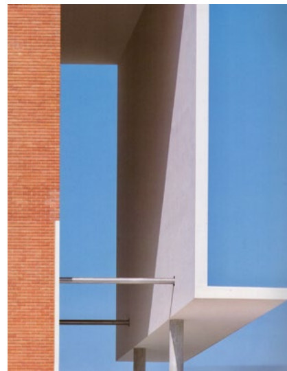
3608. Detalle de fachada.
