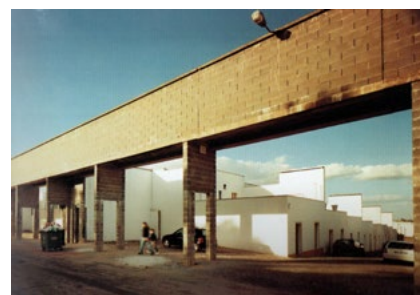
3129. Viviendas populares adosadas al acueducto de Água de Prata, en el casco histórico de Évora.
