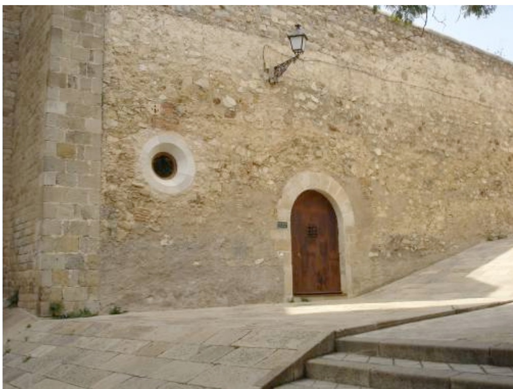
Aspecte actual de la porta (2008).
