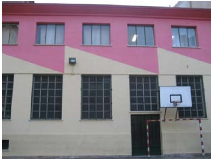
fig. 16: Vista del gimnàs de l'institut
