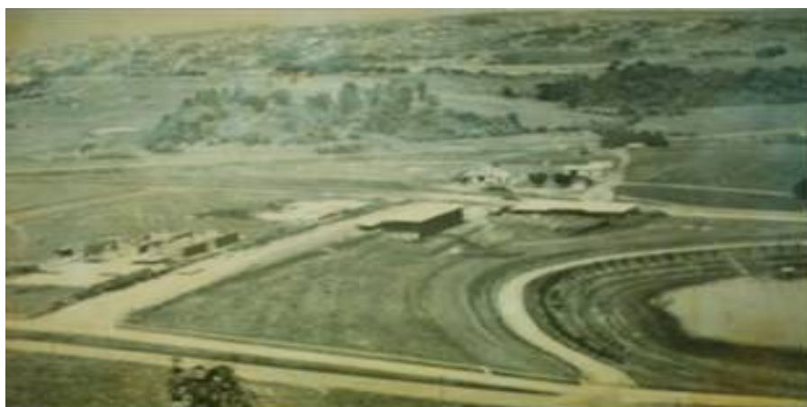
Figura 207 Construcción de los primeros edificios del Campus I en la década de 1970 (Guareschi 2001, v. 5, 52).
