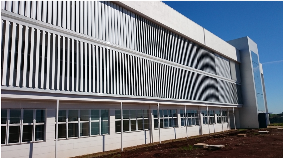
Figura 295 Protección solar fachadas Leste y Oeste. Edificio V2 – Nova FEAR (fotografía del autor 2015).
