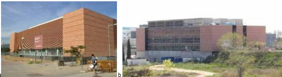
Figura 197 a. Edifici de Serveis – fachada Sur; b. Edifici de Serveis – vista noroeste (fotografías del autor 2006).
