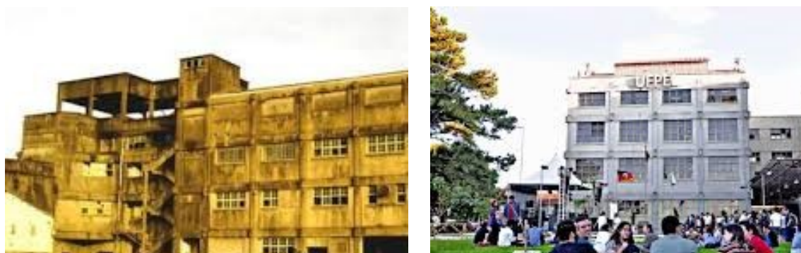
Figura 322 Campus Anglo UFPEL: imágenes de la situación anterior a la intervención (Frigorífico Anglo) y actual (UFPEL 2015).
