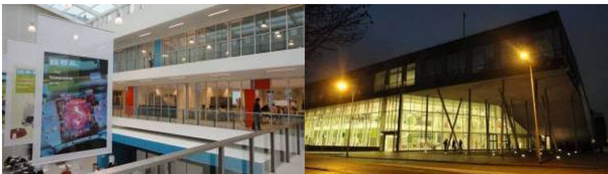
Figura 99 Escuela de Ingeniería de la The Haguen Universitat. DWA, 2009 (Fotografías del autor 2010).
