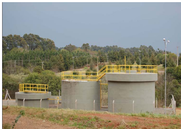
Figura 164 Estación de Tratamiento de Agua Residual UPF con sistema anaeróbico (fotografía del autor 2008).
