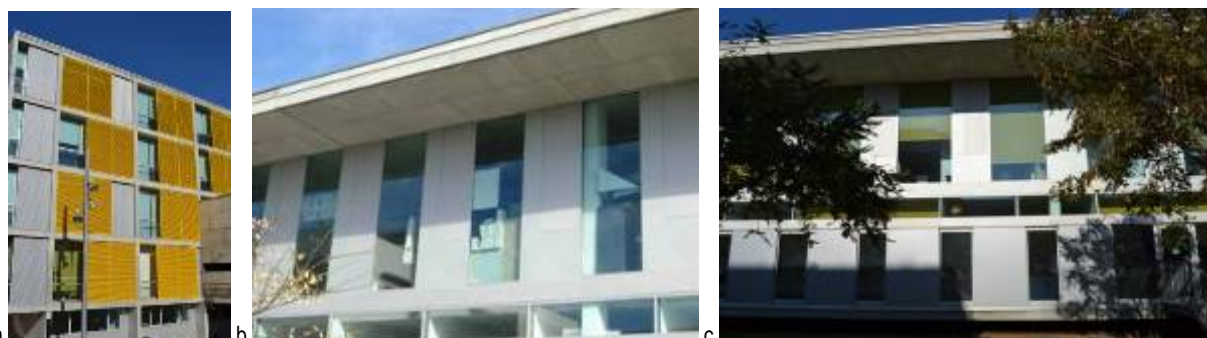
Figura 146 a. ESAB - protección solar aulas; b. ESAB – protección solar “alternativa” (fotografía del autor 2006); c. protección solar interna (fotografía del autor 2012).
