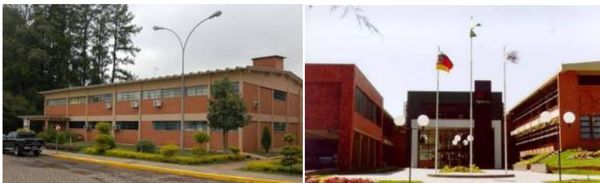
Figura 25 Tipologías de los edificios de UPF: Facultad de Agronomía; 1999 (Fotografía del autor 2006).
