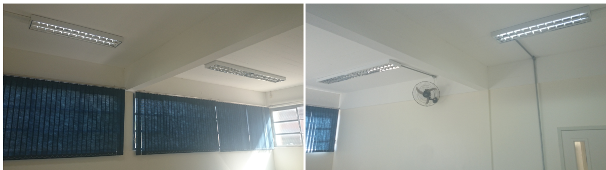
Figura 54 Sala 15 – H2 con lámparas LED 22W ZL-2810 (fotografías del autor 2014).
