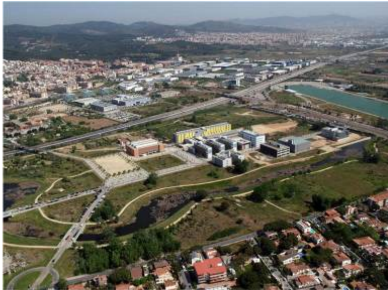
Figura 136 Vista aérea del Campus del Baix Llobregat (Castelldefels) - Parc Mediterrani de la Tecnologia, sin fecha (PMT 2011).
