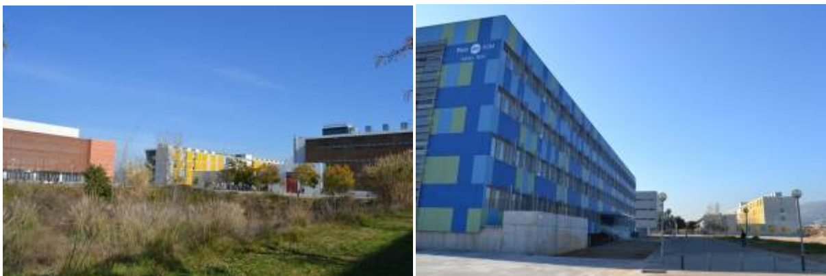
Figura 137 Vistas generales del Campus del Baix Llobregat - PTM (Fotografías del autor 2012).
