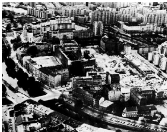
Fig. XX. Fotografía a vista de pájaro de Frankelufer en 1979, tras las demoliciones para llevar a cabo la planificación anterior a la fundación de la IBA. Fuente: Fig. XX. Planta del emplazamiento del proyecto para Frankelufer (1979). Fuente: Senator für Bau- und Wohnungswesen. (1984). Bauen und Wohnen in alter Umgebung – Wohnen in der Innenstadt. Beitrag des Bezirks Berlin-Kreuzberg zum Bundeswettbewerb "Bürger, es geht um Deine Gemeinde", IBA, Berlin, p67.
