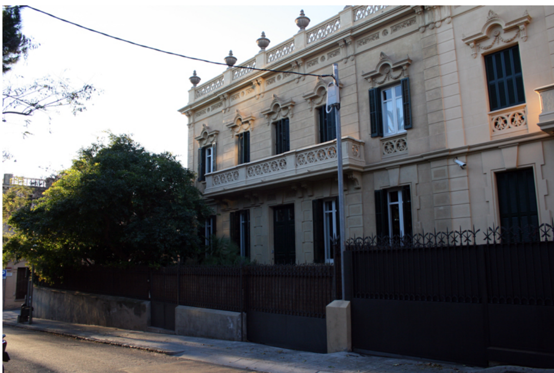
Casa de Leslie i Ramon Folch al carrer Margenat. (Fotografia de l'autora de la tesi).
