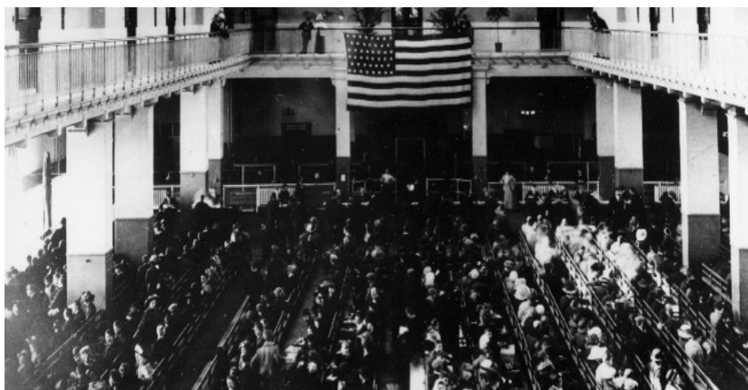
Register Room (Great Hall), Illa d'Ellis, a començaments del segle XX 75
