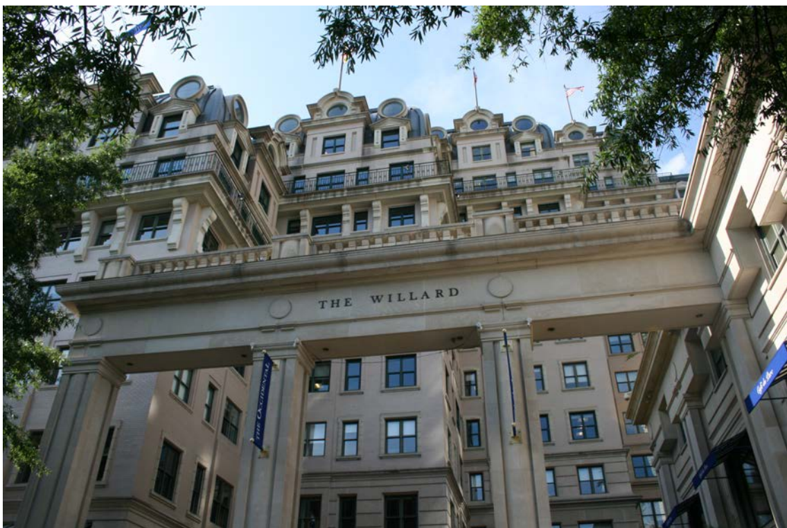
Intercontinental The Willard, Washington. (Fotografia de l'autora de la tesi, 2015)
