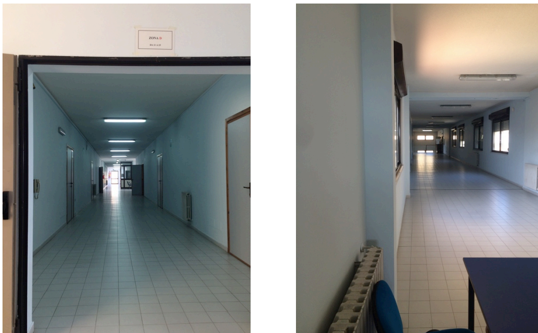
Fig. 44 - Disposición panóptica del lugar de control del personal auxiliar del Instituto italiano. Vista en perspectiva, en dos direcciones perpendiculares, desde el mismo lugar. Contexto B de observación – Italia.
