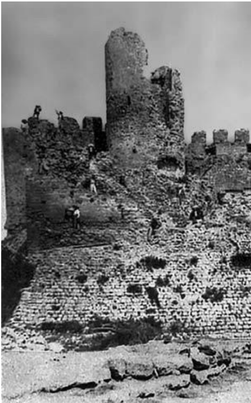
Fotografia anterior a la reconstrucció del castell de Castellet o de Sant Esteve dels anys 1928-1929.
