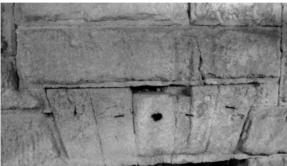
Detalls de les dovelles de les finestres altimperials reaprofitades en la construcció romànica Dela canongia de la segona meitat del segle XII. Fotografies de J.Ruiz de Arbulo.
