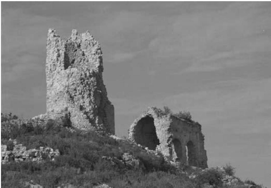
Estructures conservades de la fortificació de castellvell de la Marca: torre de planta circular i nau amb coberta de canó.
