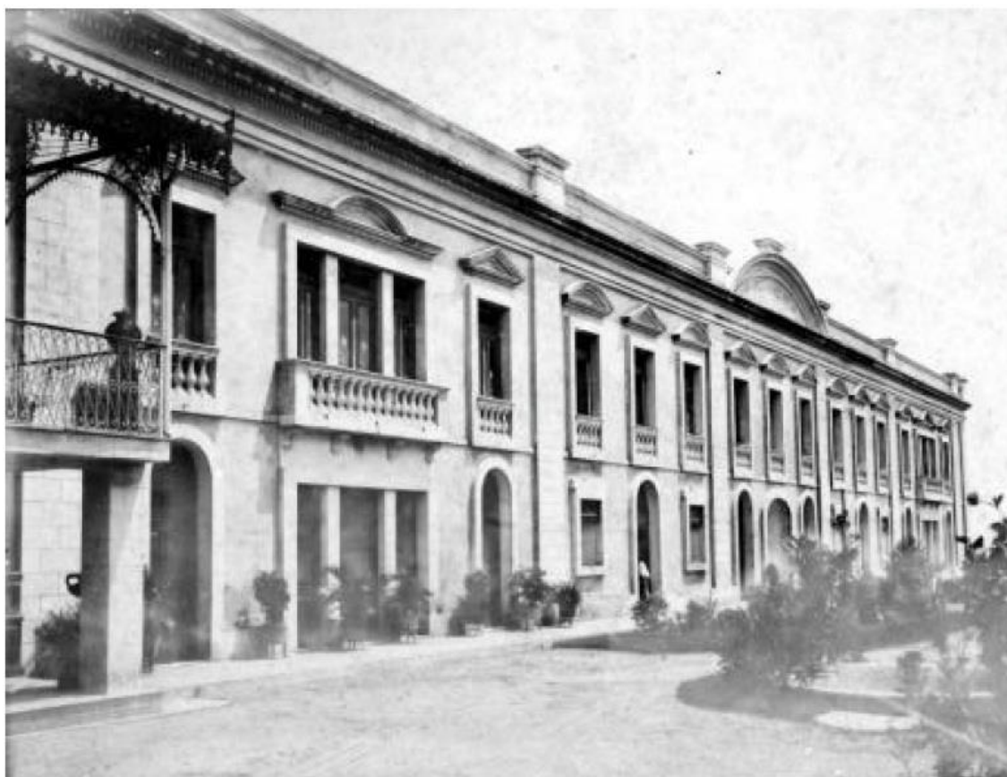
Figura 8.4 Fachada lateral e interna do Palácio do Governo
