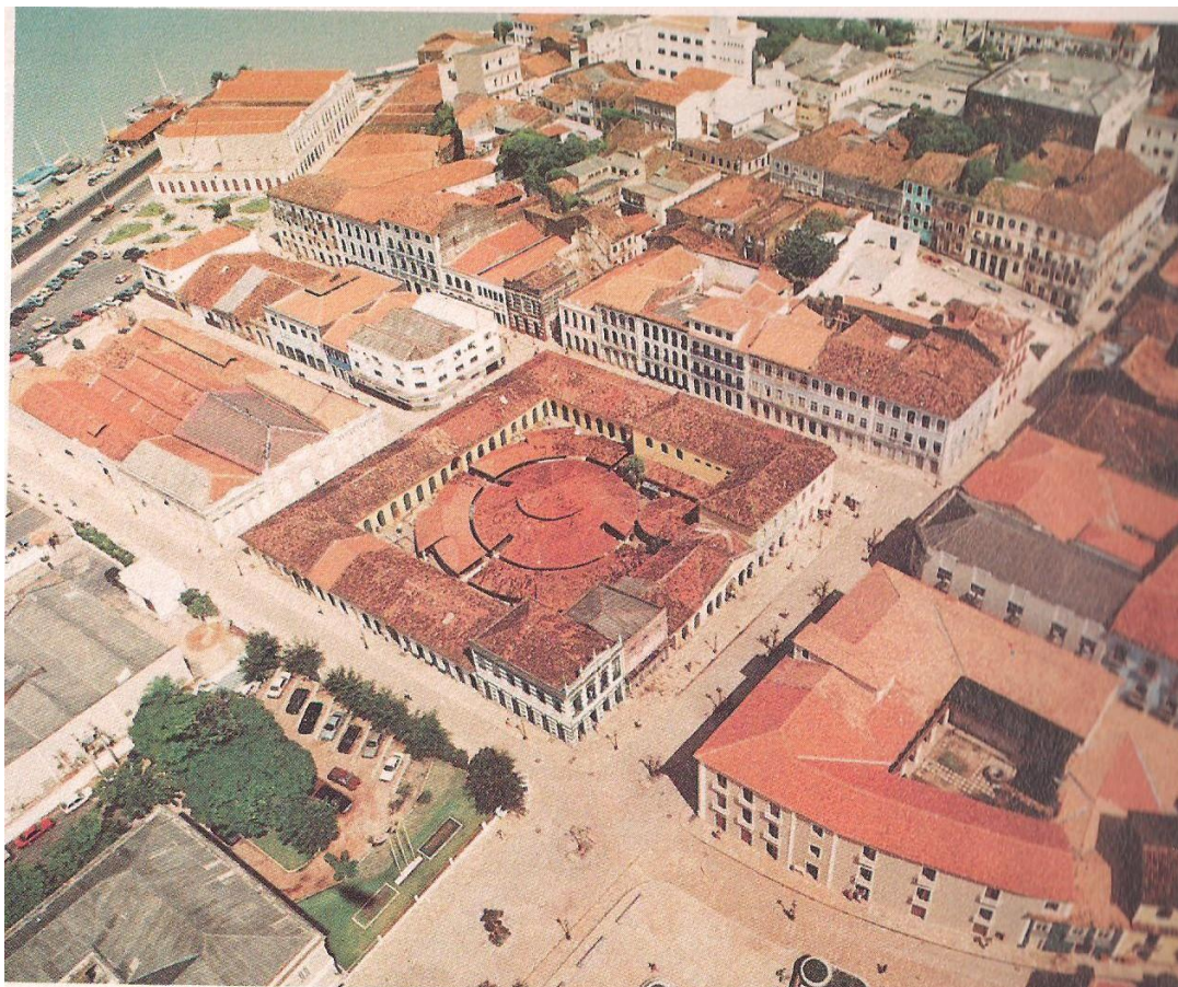
Figura 9.6 Vista aérea da feira da Praia Grande com as obras já concluídas localizada no centro da foto
