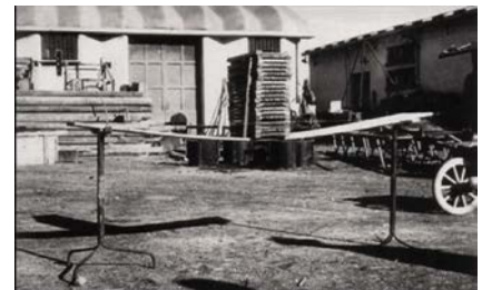
Fig 3-2-47: ISMES. (Izq.) Modelo de estudio para la estructura con curvatura. (Der.) Pruebas de carga, y las maquinas que se
