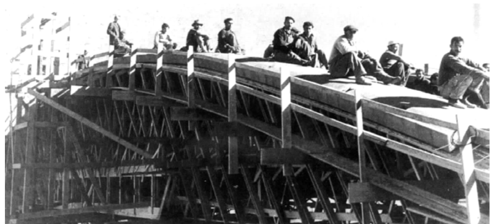
Fig. 3-2-43 y 3-2-44: Prueba de carga con la totalidad de los obreros y al fondo el propio ingeniero Dieste.
