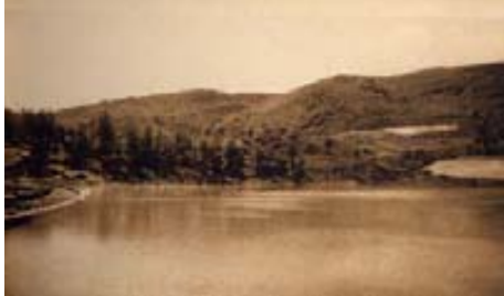
Figura 8.16. La presa del Pantà Gros de Santa Fe.
