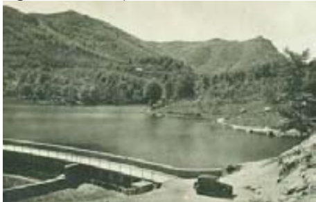
Figura 8.17. La presa del Pantà Gros de Santa Fe.
