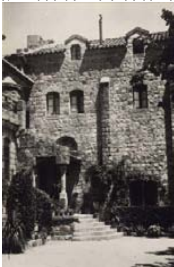
Figura 8.3. Entrada de l'hotel de Santa Fe
