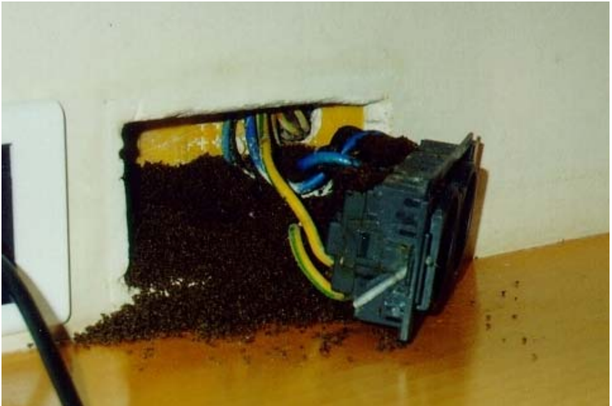
Figura 8. Fotografia corresponent a un endoll d'una de les cases situades al centre de la zona ocupada per Lasius neglectus a la població B (Matadepera). Les formigues mortes s'acumulen dins les caixes i les conduccions elèctriques, suposadament transportades per les obreres (Fotografia cortesia de Monserrat Jorba, Matadepera).
