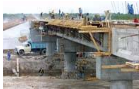
Construcción de nuevo puente Diario El Litoral . 30/04/2004. "En el departamento San Justo se invierten 80 millones. Consultado 09/05/2012. www.ellitoral.com/index.php/diarios/2004/10/30/regionales/REGI-01.html
