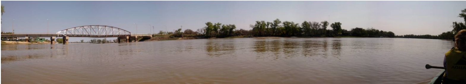
Puente sobre el río Arroyo Potrero. Google Panoramio http://www.panoramio.com/photo/41058673?source=wapi&referrer=kh.google.com http://www.panoramio.com/photo/60394412?source=wapi&referrer=kh.google.com
