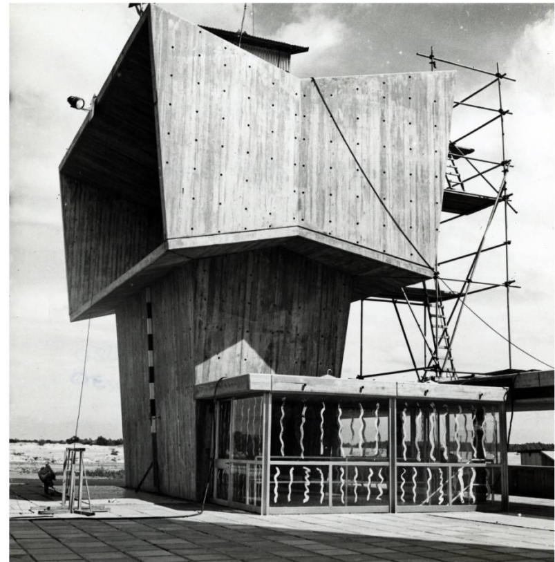
16. El viaducto Oroño / 17. El túnel Subfluvial / 18. Chimenea de ventilación del túnel. La construcción de la infraestructura de movimiento a fines de la década de 1960.
