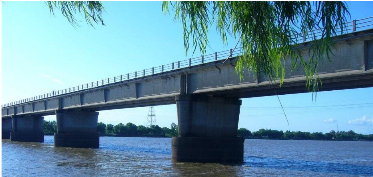
Puente sobre el río Colastiné. AGN / Google Panoramio. http://www.panoramio.com/photo/6592751?source=wapi&referrer=kh.google.com
