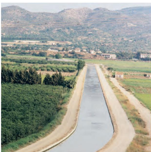
Revestiment dels canals i instal·lació de la canonada de distribució del CAT. FOTOS: Carot, 2014.
