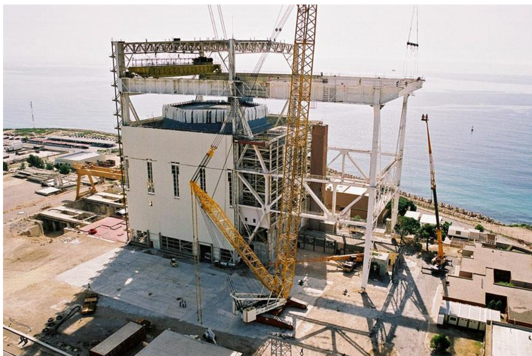
Treballs de desmantellament de Vandellòs I, actualment en període de latència. FOTO: ENRESA
