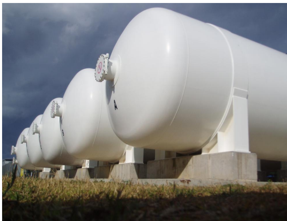
Dipòsits d'aigua a les instal·lacions de la dessalinitzadora de Blanes.
