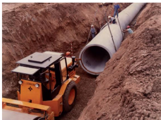
Revestiment dels canals i instal·lació de la canonada de distribució del CAT. FOTOS: Carot, 2014.
