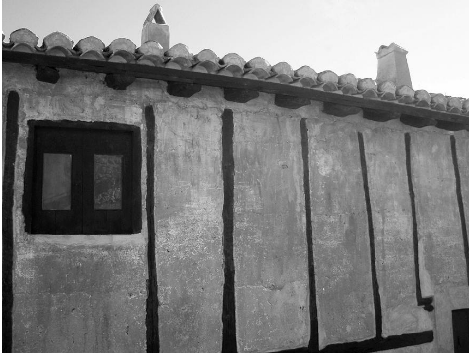
Fig. 2: Fachada lateral casa localidad de Albarracín
