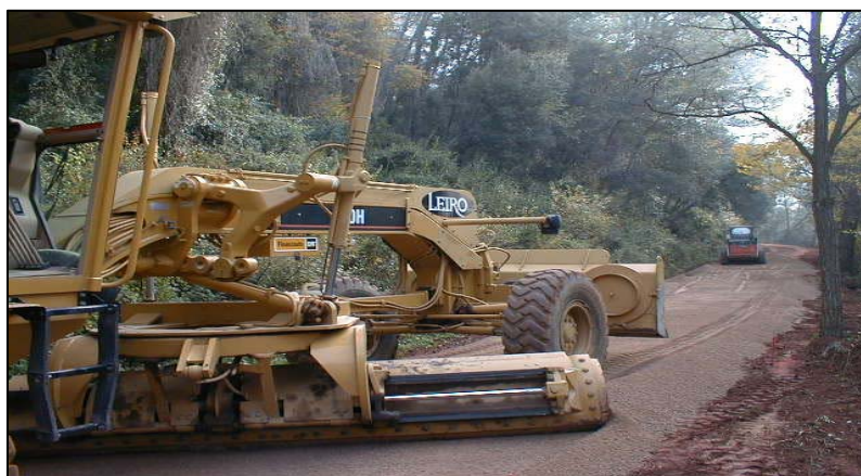
Foto 5.7: Extensión del árido natural todo uno.
