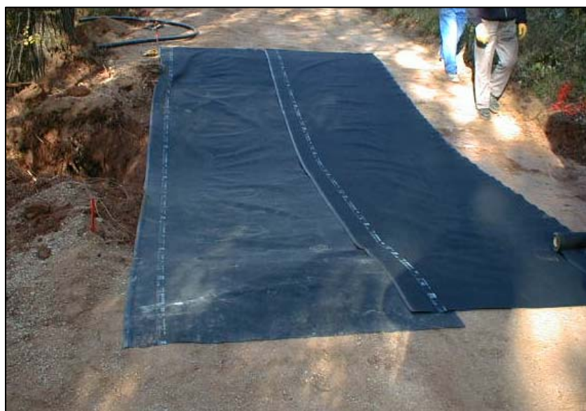
Foto 5.9: Tela asfáltica para impermeabilizar la zona de bacheo.
