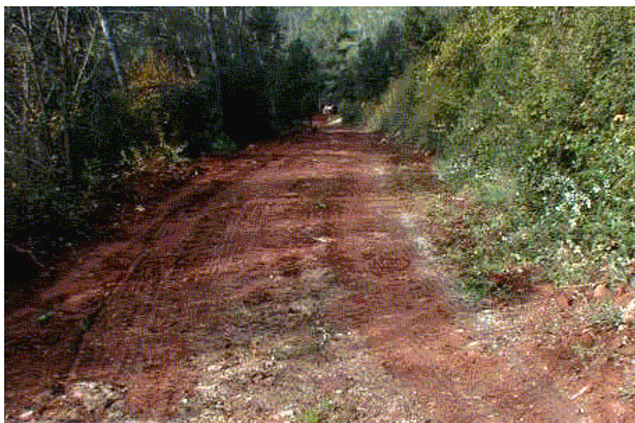
Foto 5.1: Carretera ubicada en un corte de montaña.
