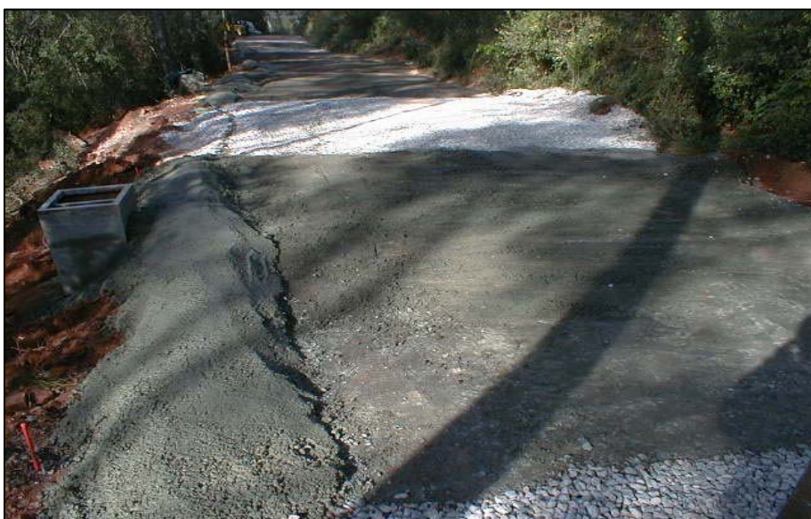
Foto 5.4: Pequeños muros de contención lateral.
