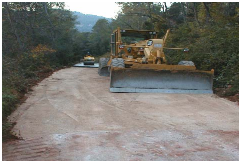
Foto 5.2: Preparación de la explanada
