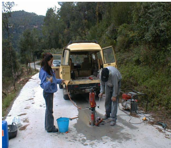
Foto 5.15: Extracción de los testigos
