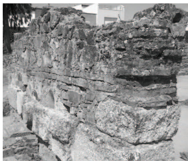
Fig. 81. Una fotografia de la fàbrica amb la que s'aixequen els murs de la " Casa del Teatro " (Mèrida). En aquest cas s'ha observat que la majoria dels materials són d'aprofitament, encara que es tracta d'una casa de cert luxe (A. Perich).
