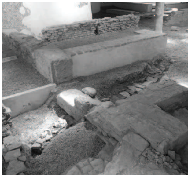
Fig. 106. Fotografia de l'antic llinard de la "Casa de la Nimfa". El canvi més apreciable en aquest moment és la presència d'una nova canonada d'evacuació per a les aigües procedents del nou peristil de la "Casa de la Columna" (A. Perich).
