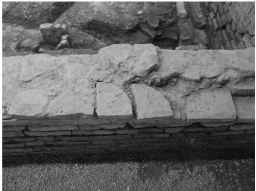
Fig. 116. Fotografia d'un dels murs de tancament de perimètric del peristil localitzat a la "Casa del Sigma" (inicis del s. VI). S'observen elements d'aprofitament, com ara fragments de columnes ceràmiques (A. Perich).
