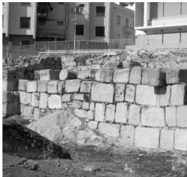
Fig. 10. Fotografia de la muralla d'època visigoda a Emerita Augusta (Mèrida), al tram de Morería. L'heterogeneïtat de la fàbrica revela les diverses procedències del material constructiu, on destaquen carreus i tancers. El reforçament visigot s'ha localitzat només en alguns punts (A. Perich).
