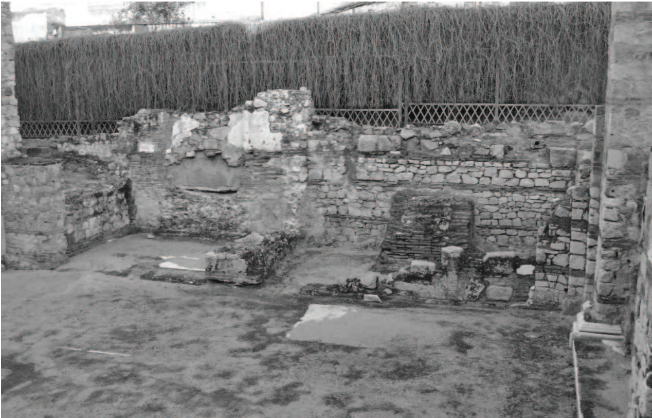
Fig. 24. Fotografia de l'extrem nord-oest de l'anomenat "forum adiectum" de Mèrida. Després de les fases d'espoli, aquesta cantonada de l'antic recinte foral serà aprofitada per a la construcció d'una casa de planta baixa i primer pis, que cronològicament se situa en època visigoda (Autoria: Álvaro Corrales Álvarez).
