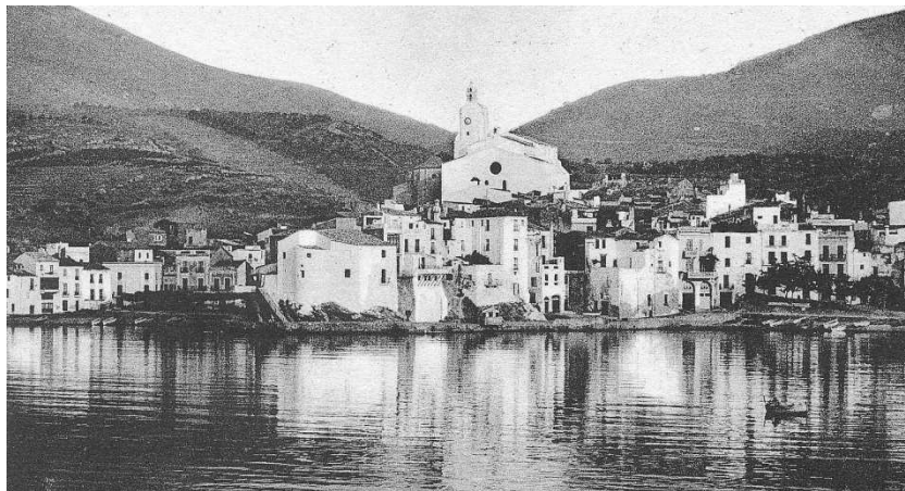
Panoràmica de l'església de Cadaqués, obra civil del segle XVII, a la que s'abocaren molts diners procedents de la pesca, tant en la construcció com en l'adobament de l'interior: parament religiós, retaule, et. Font: Museu de la Pesca.
