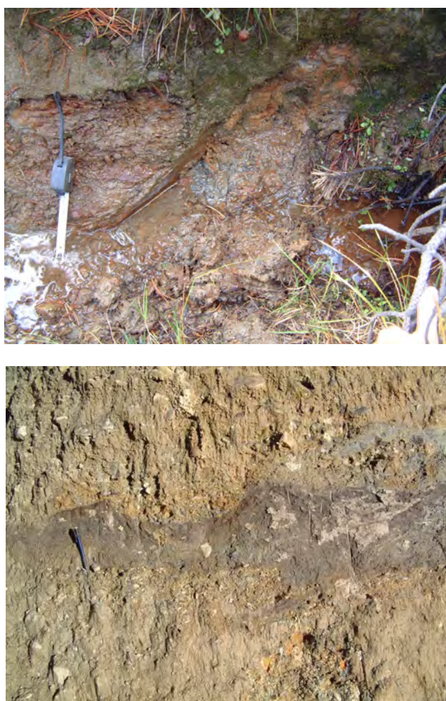
Fig. 5. 7 Arriba: Detalle de una falla menor desarrollada en materiales limosos encontrado en un afloramiento reducido cerca del afloramiento N1-localidad 2. Abajo: Lentejón de material limoso en el afloramiento S1-localidad 1. La deformación de la base del material limoso podría estar causada por la reptación de la ladera o por el paso de la lengua glacial sobre los depósitos de Priedo .
