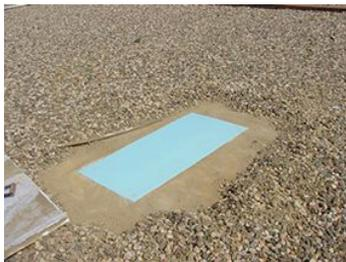
**Foto 6.6.** Poliestireno extruido XPS, en cubierta. (Fuente: Dow Chemical <http://building.dow.com/europe/es>, acceso agosto 2014).
