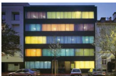
Figs 118 y 119. Heinrich Degelo, edificio de viviendas Bonifacius, Basilea, (2008-2010)
