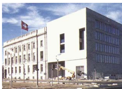
Fig. 89. Roger Diener + Helmut Federle. Embajada suiza en Berlín (2000). Vista del conjunto desde el sureste.
