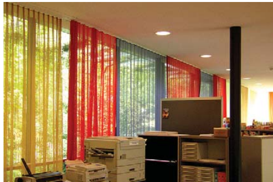
Fig. 160-162. Herzog & de Meuron + Adrian Schiess. Edificio de Marketing de la empresa Ricola, Laufen (1998)
