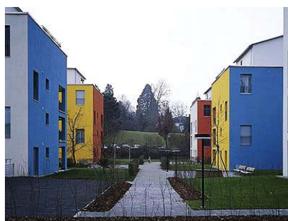
Fig. 123. Jean Pfaff, intervención en viviendas, Aarau (2000)
