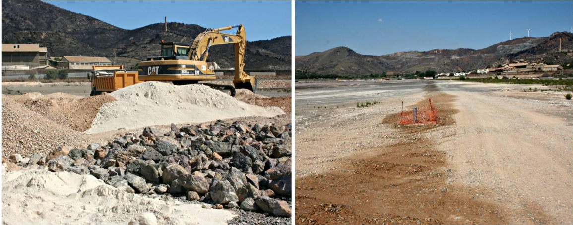
Figura 5. 8. Equipos excavación convencional durante la construcción, y aspecto exterior de la barrera tras su finalización.
