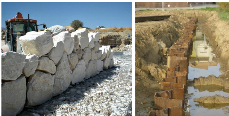
Figura 1. 4. Ejemplo de la construcción de un muro de gaviones y tablestacas ( http://diquesdegavion.eshost.es y http://tablestacas.es ).
