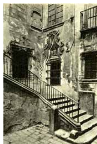
250. Montcada 15. Esquina Noroeste del patio en 1953. Fuente: Florensa, 1962.
