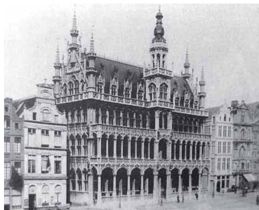
30. Maison du Roi después de la intervención de Buls. Fuente: Smets, 1995.
