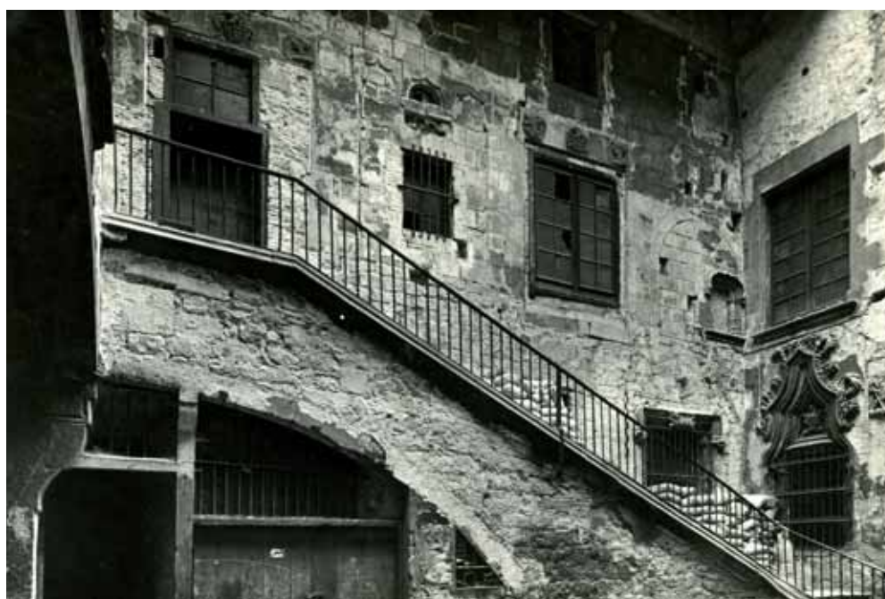
251. Montcada 15. Estado de las ventanas de la esquina Noroeste del patio en 1954. Fuente: Archivo Fotográfico, Urb. 2494.
