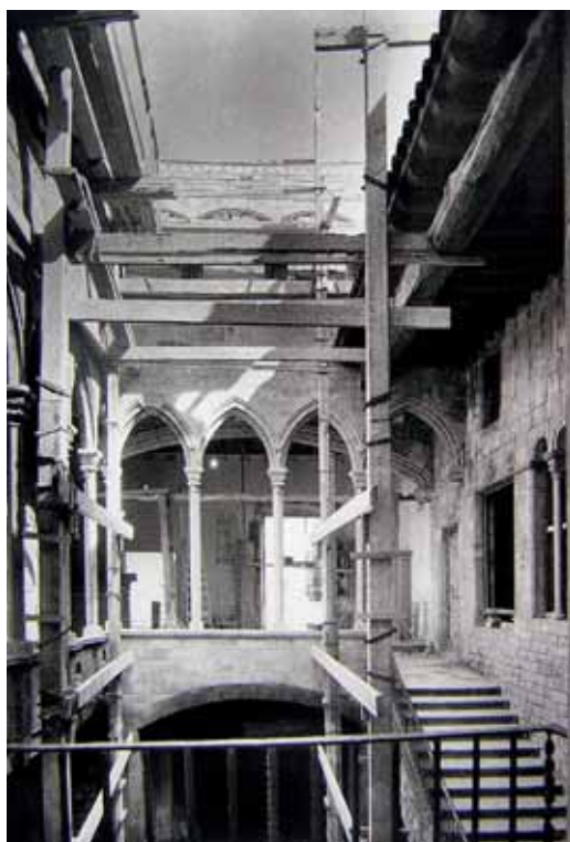
252. Montcada 15. Patio durante la intervención. Fuente: Maristany, 2007.
