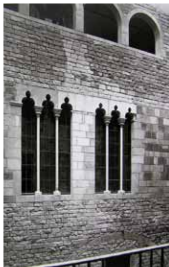
255. Montcada 17. Ventanas y galería reconstruidas. Fuente: Maristany, 2007.
