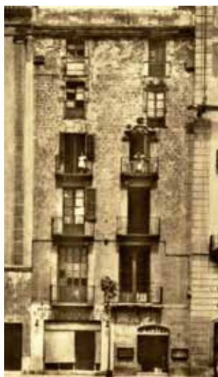
221. Paseo de Colón 2 antes de la intervención. Fuente: Florensa, 1949.
