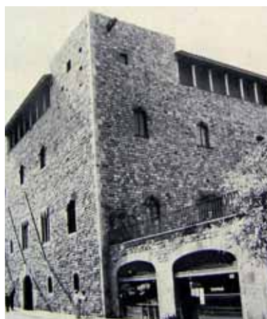
203. Calle Archs 5 y 7 después de la intervención. Fuente: Catàleg, 1987.
