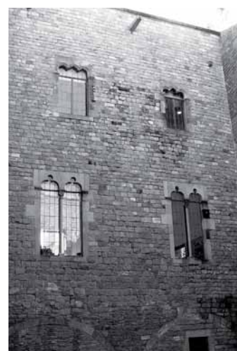
233. Patio del Palacio Requesens. Nuevas ventanas colocadas por Florensa. Fuente: foto del autor.
