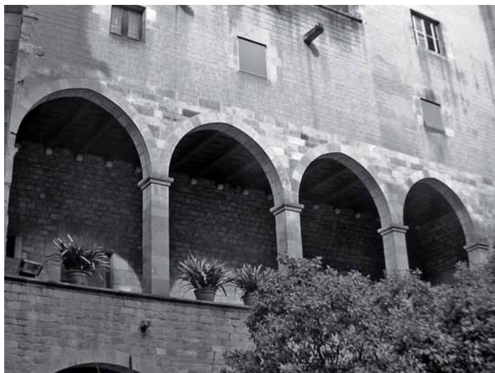
176. Galería en la cara Noroeste del patio en la actualidad. Fuente: foto del autor.
