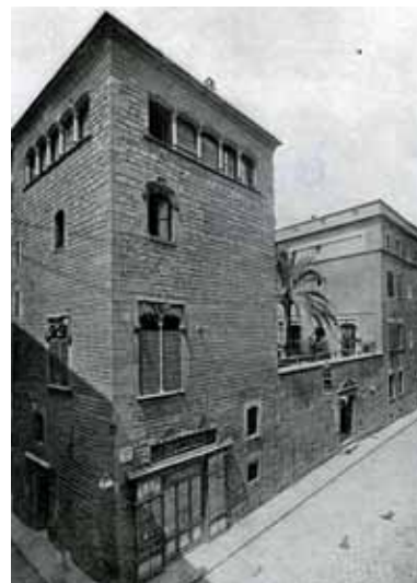
191. Casa del Arcediano en 1917. A la derecha, la casa del Deán presenta el mismo volumen que la torre del siglo XVI. Fuente: SPAL, Cat. Monumental, Caja 498.
