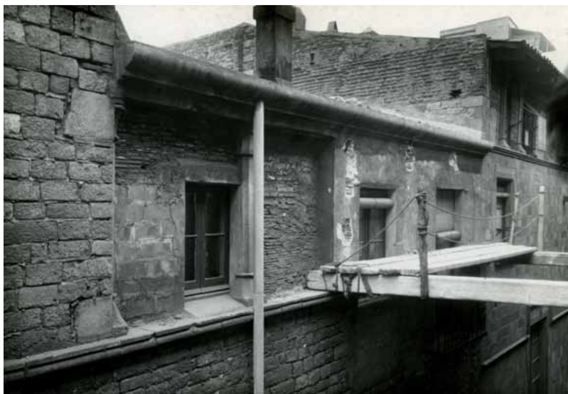
258. Montcada 23. Galería de la fachada antes de la intervención. Fuente: Archivo Fotográfico, Urb. 2998.
