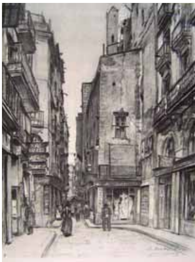
52. Calle Tapinería antes de los derribos. D. Baixeras, 1908. Fuente: Duran i Sanpere, 1947.
