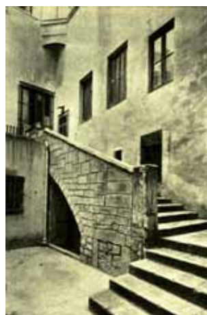
261. Montcada 23, patio antes de la intervención. Fuente: Florensa, 1962.
