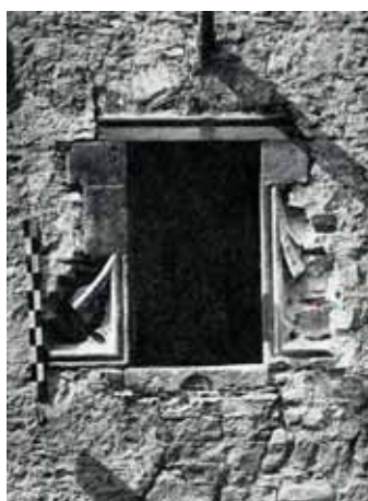
246. Montcada 15. Ventana en la cara Norte del patio. Fuente: Florensa, 1959-A.
