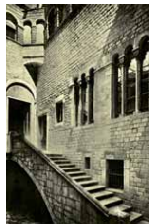
262. Montcada 23, patio después de la intervención. Fuente: Florensa, 1962.
