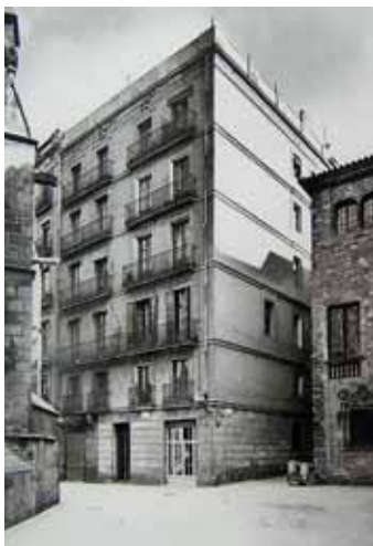
207. Las casas antes de la intervención. Fotografía de 1966.
