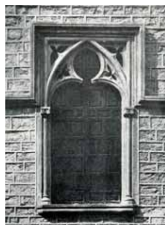
247. Montcada 15. Reconstrucción de la ventana en la cara N. del patio. Fuente: Florensa, 1959-A.
