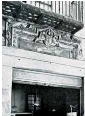
239. Montcada 15. Ventana planta baja. Fuente: Florensa, 1959-A.
