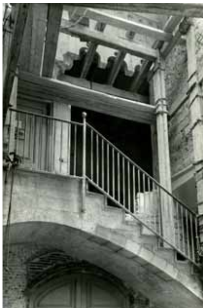
275. Restos del ventanal. Fuente: Archivo Fotográfico, Urb. 2907.
