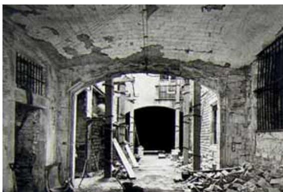
256. Montcada 17. Patio antes de la intervención. Fuente: Maristany, 2007.
