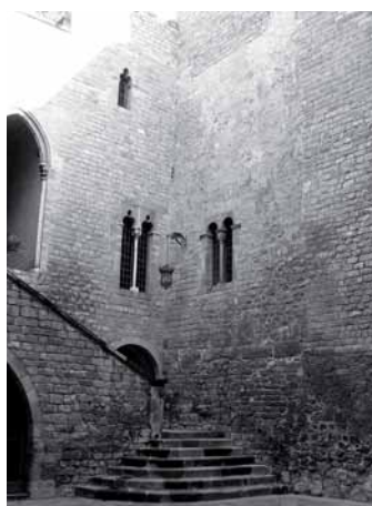
234. Nueva ventana en la base de la torre. Obra de Pallàs en 1964. Fuente: foto del autor.
