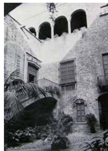
267. Montcada 12. Patio restaurado. Fuente: Catàleg, 1987.
