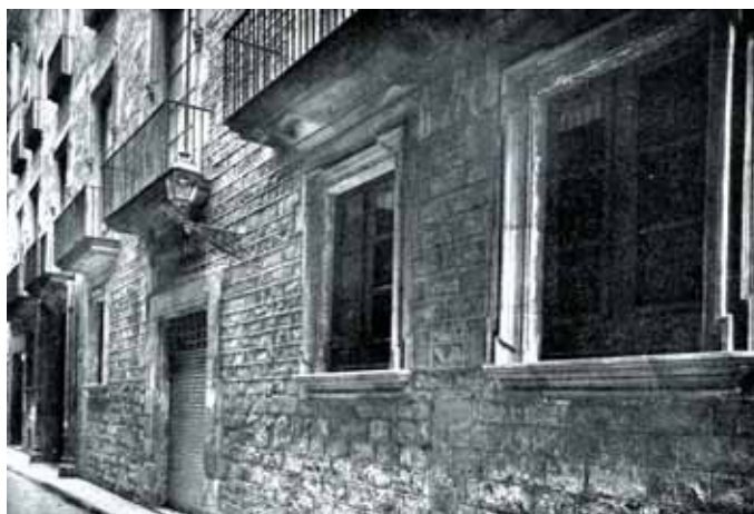
277. Montcada 20 durante la obra. Ventanas y muro reconstruido. Fuente: Florensa, 1959-A.
