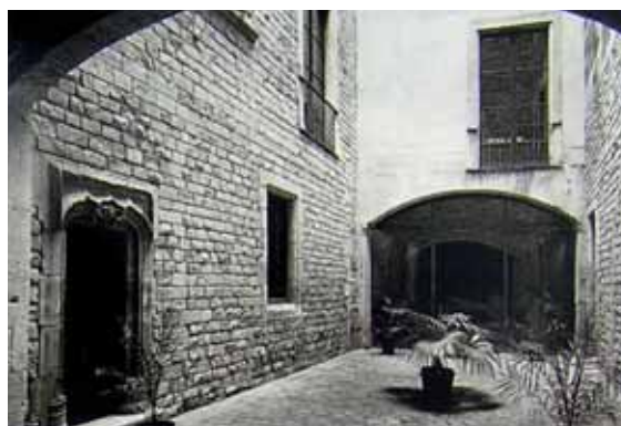
257. Montcada 17. Patio restaurado. Fuente: Maristany, 2007.
