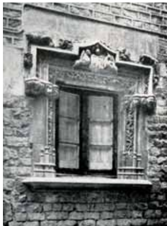
240. Montcada 15. Ventana planta baja completada. Fuente: Florensa, 1959-A.
