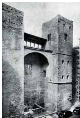
231. Fachada del Palacio Requesens hacia la calle Subteniente Navarro en 1958. Fuente: Florensa, 1958-C.
