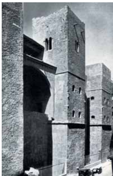
236. Reconstrucción de la parte alta de la torre contigua al palacio Requesens. 1958. Fuente: Florensa, 1958-B.
