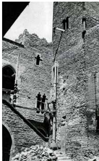
225. Palacio Requesens durante la obra. Fuente: SPAL, Catálogo Monumental, Caja 497.
