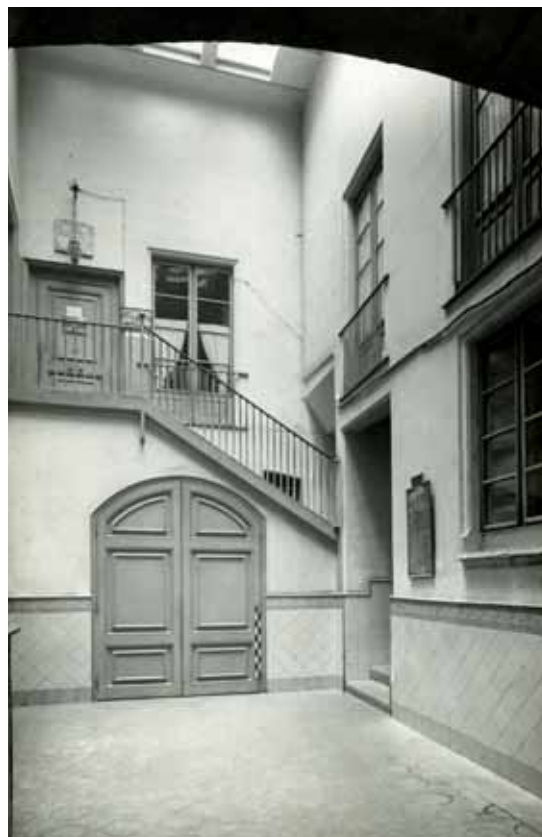
274. Patio antes de la intervención. Fuente: Archivo Fotográfico, Urb. 2807.
